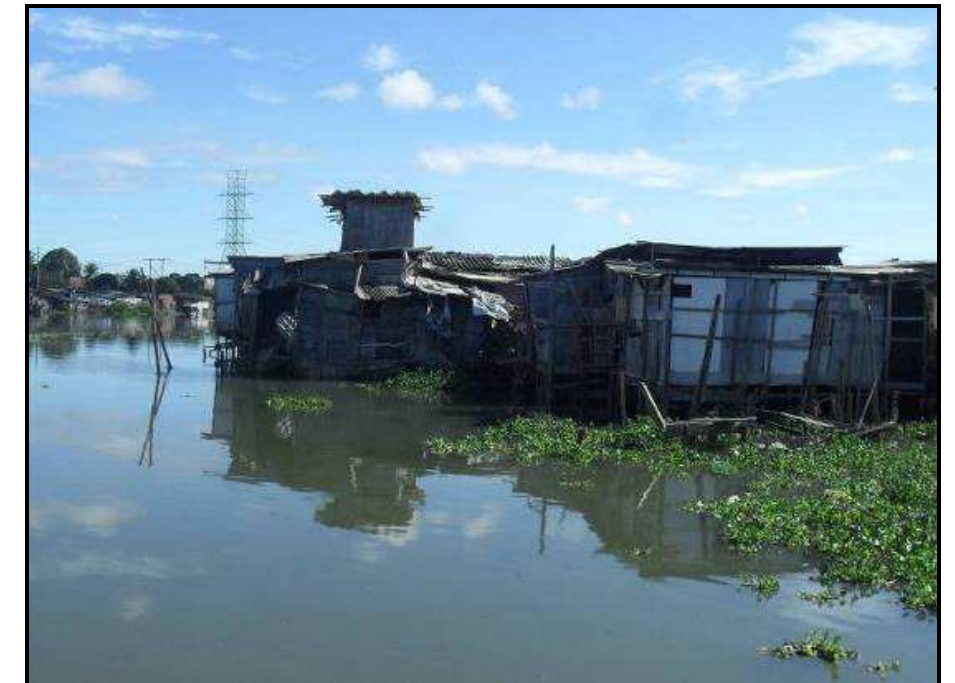
Figura 80. Imóveis sujeitos a desastres na Vila dos Coelhos. Foto: CARUSO JR. E. A. E., 2012.
