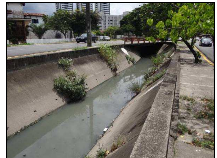
Figura 32. Canal de drenagem localizado na rua Real da Torre, esquina com rua Nobre de Lacerda, bairro Madalena em Recife. Foto: CARUSO JR. E. A. E., 2012.
