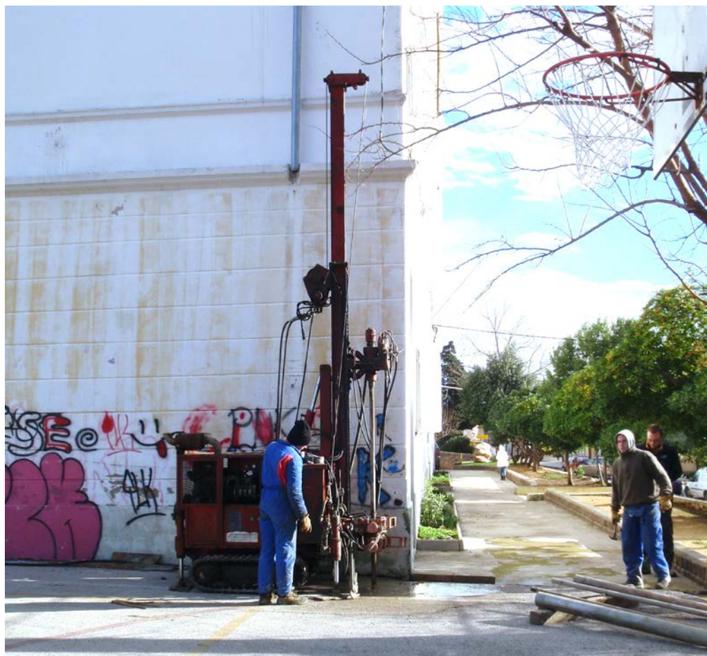
■ Istraživačko bušenje, Baška, otok Krk (Foto: Č. Benac)
