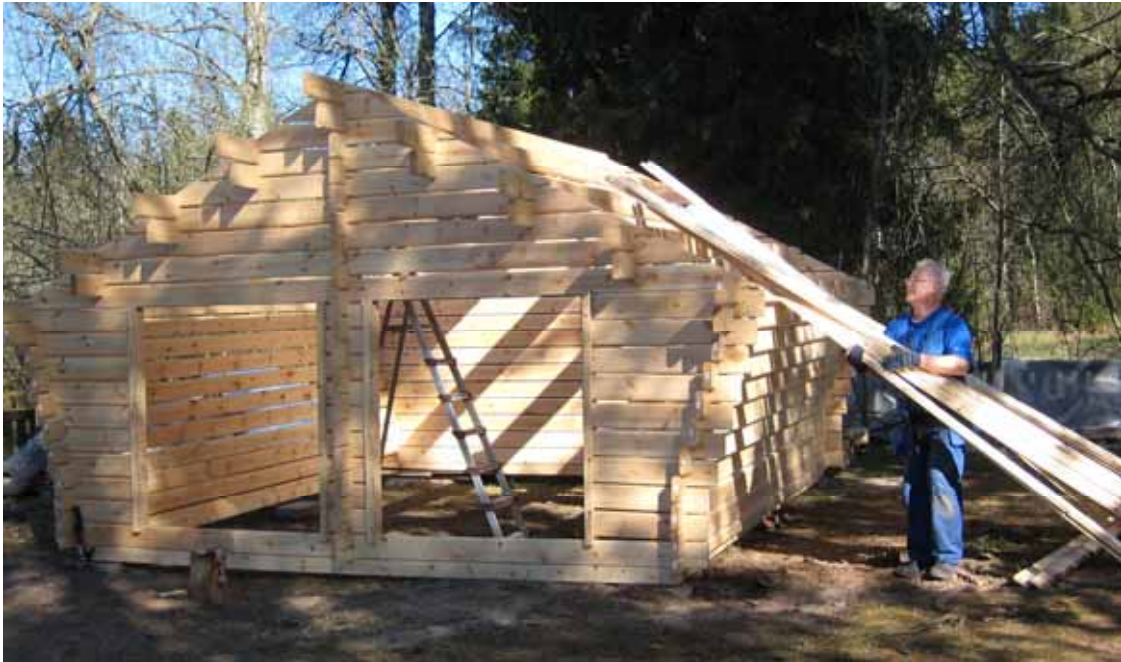
Koivulan avustamisprojektin puuhämies Jukka Mustalahti puuvajaa rakentamassa.
