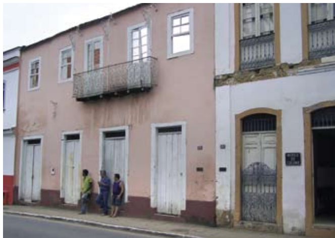
As belas fachadas em Santa Leopoldina
