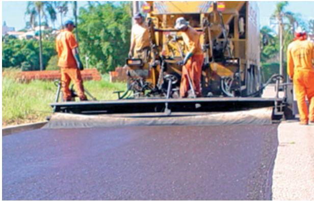
Figura 8.36 Exemplos de aplicação de lama asfáltica
