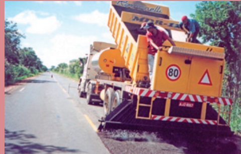
(b) Equipamento multidistribuidor em operação
