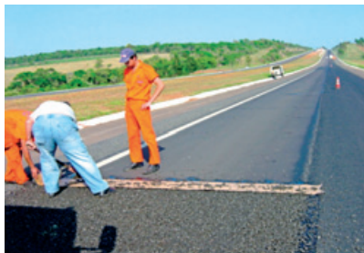
(a) Demarcação do início de aplicação de ligante asfáltico
