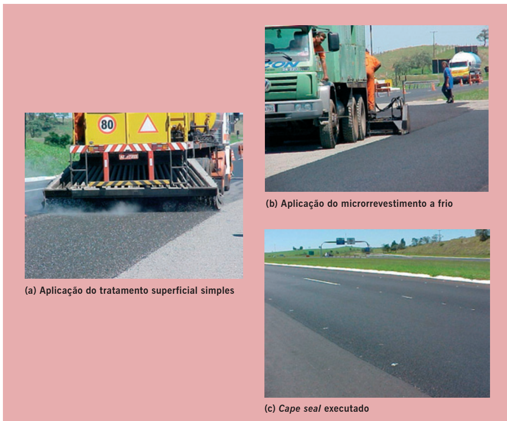
Figura 8.38 Etapas da execução de cape seal (Fotos: Greca Asfaltos S.A.)
