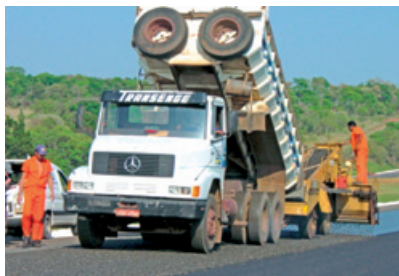
(c) Distribuição de camada de agregado
