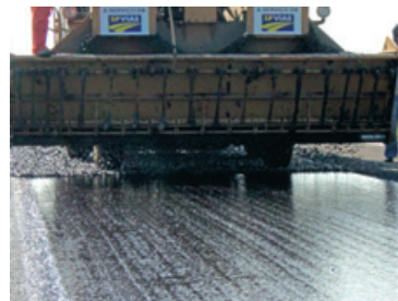
(d) Detalhe da distribuição de agregado
