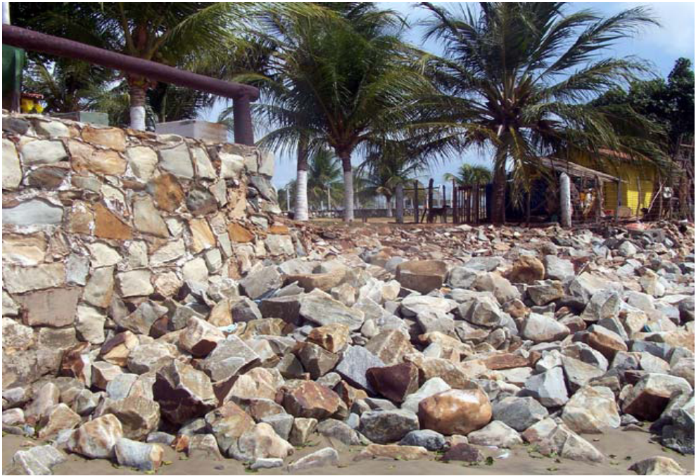
Figura 11 - Restaurante localizado no local teve seu muro destruído pelas ressacas no mês de janeiro de 2006. Paracuru – CE.
