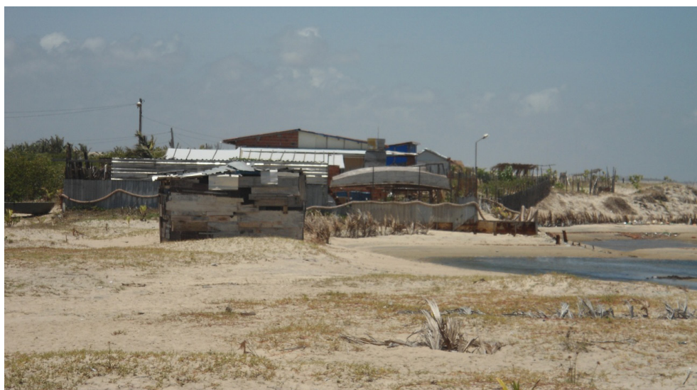
Figura 13 - Ocupação da praia. Pecém, São Gonçalo do Amarante – CE.
