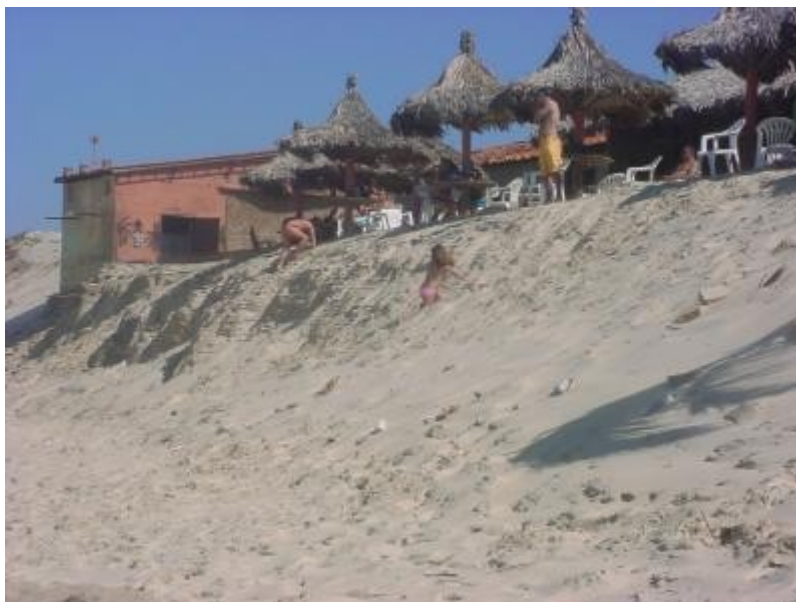
FIGURA17: Barraca Praia e Sol no Icaraí tirada em Março de 2006. Atualmente, não existem mais esses quiosques em frente da barraca, nem os banheiros que aparecem no lado esquerda da foto.
