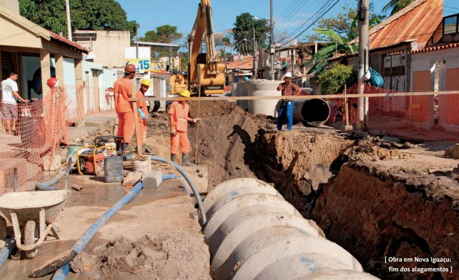
foi rasgada de ponta a ponta para a implantação de galerias da rede de macrodrenagem pluvial.
