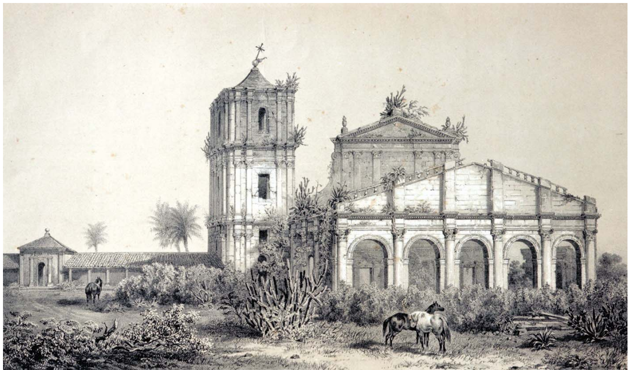
Ruínas de São Miguel Arcanjo, 1846, Demersay.
