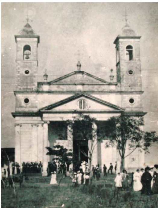
Imagem 07: Igreja Matriz frente à praça central, inaugurada em 1861. Fonte: Arquivo Municipal
