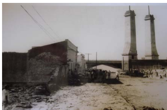
Imagem 54: construção da ponte e demolição de edificações. Fonte: Arquivo pessoal Luciano Dias.
