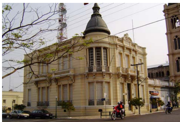
Imagem 32: Imagem atual da antiga residência da família Bárbara, construída em 1913. Atual Centro Cultural da cidade. Fonte: Arquivo Municipal
