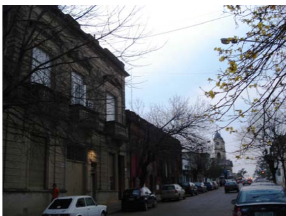
Imagem 97: Rua que leva a praça central, frente a Igreja. Fonte: Pesquisa de campo da autora.
