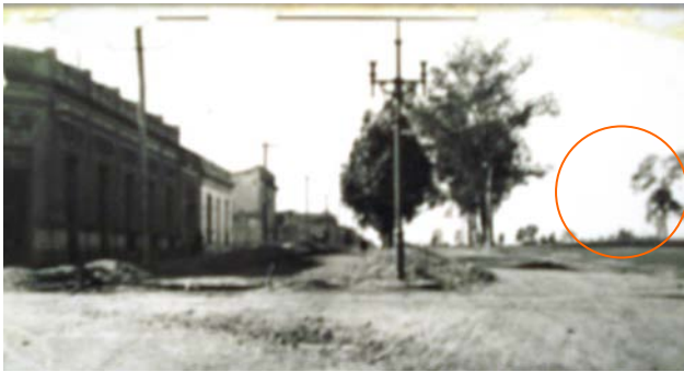
Imagem 78: 1) Primeiras obras, ainda na fase do saneamento, ruas ainda não pavimentadas, ainda nomeada Av. Riachuelo, e um canteiro central, provavelmente década de 30. Fonte: Arquivo Municipal
