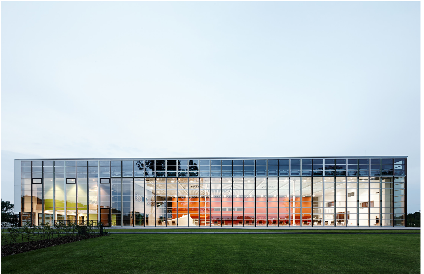
SÜDOSTFASSADE MIT GESCHLOSSENEN TOREN
