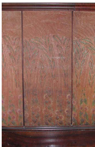
Fig. 278. Casa Ramon Oller, 1900. Detall arrambador i sostre de menjador. Es poden comprovar les diferències de detalls amb la fotografia guardada a l'Arxiu Mas (fig. 272 ) que s'ha atribuït tradicionalment a la Casa Ramon Oller.
