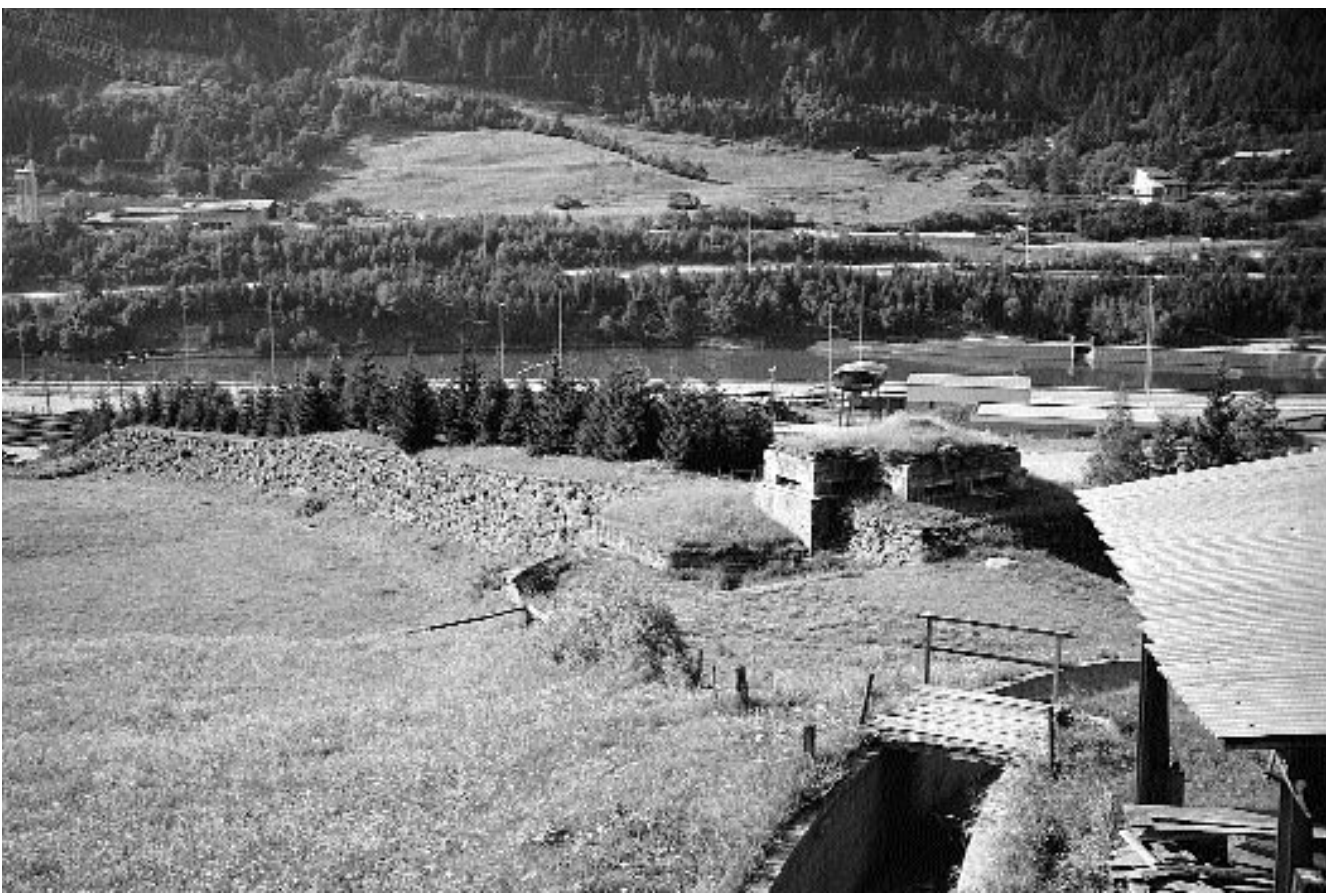
Unten: heutige Situation der Tunneleinfahrt von Norden
