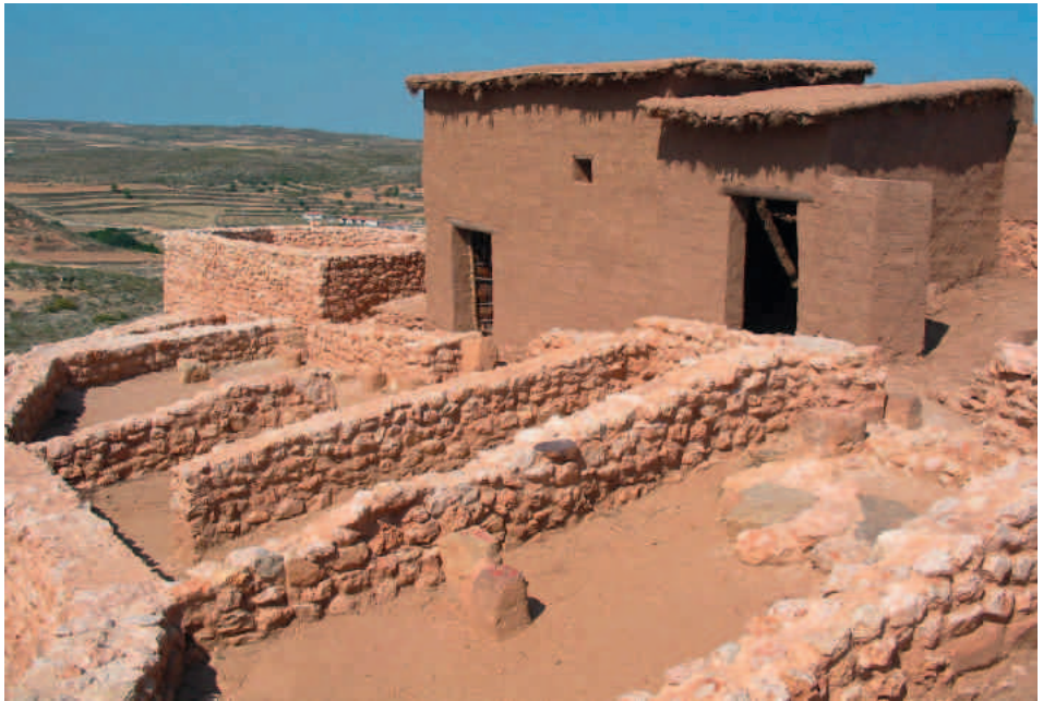
Reconstrucción en alzado de dos estancias del poblado ibérico de El Cabo (Andorra), utilizando adobes, maderos y entrelazando ramas de pino para crear la techumbre
