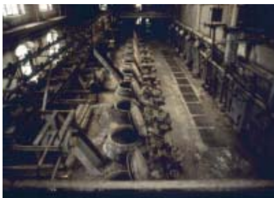
Azucarera de Alagón. Interior de la nave de fabricación
