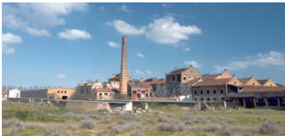
Vista general de la antigua azucarera de Alagón
