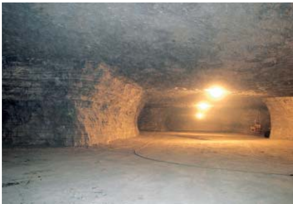
Remolinos. Interior de la mina María del Carmen
