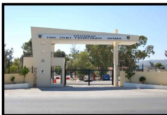
Εικόνα 48. Πύλη Οχημάτων ΣΠΒ
