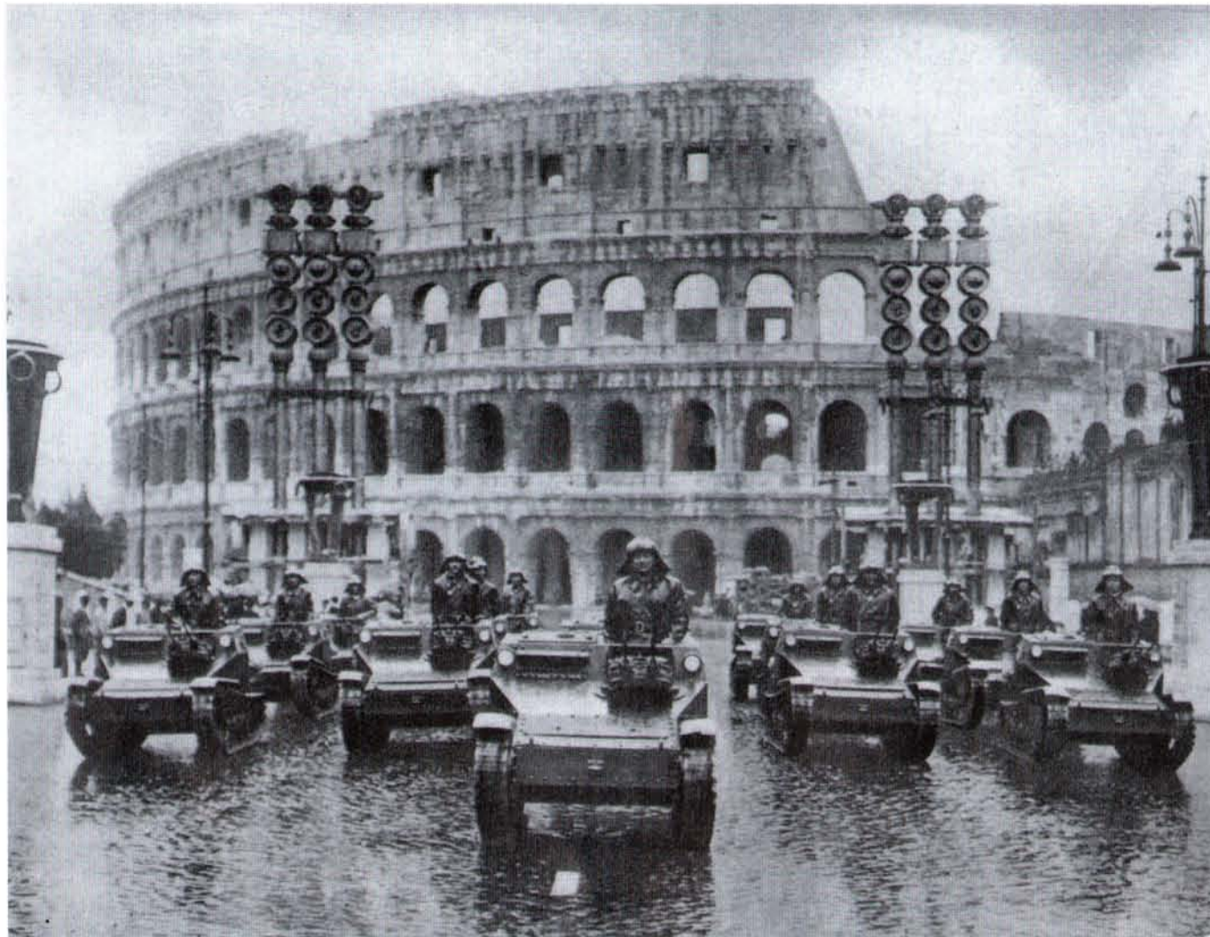
Roma, maggio 1938: sfilata del 4° Fanteria Carrista alla rivista della visita di Adolph Hitler. Per l'occasione a questo reggimento erano stati aggregati tutti i quattrocento carri L3/35 allora disponibili in Italia. Fu considerato un miracolo il fatto che in un percorso di circa 100 km nessun carro incorresse in avarie.
