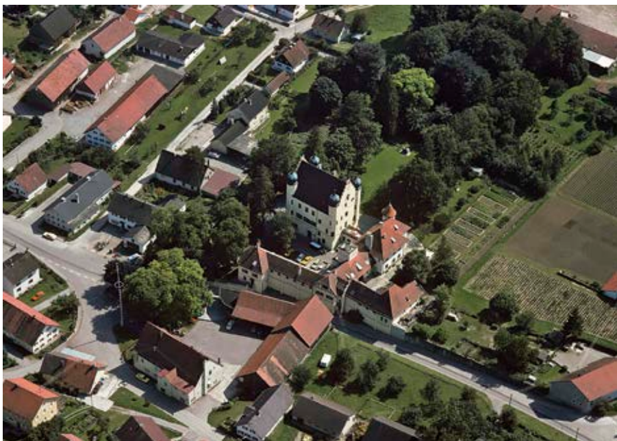
Hurlach, Lkr. Landsberg a. Lech. Ortsbereich mit Schlossanlage (Foto: BLfD, Luftbilddokumentation, Archiv-Nr. 7930_002_409_5, Otto Braasch, 1979)
