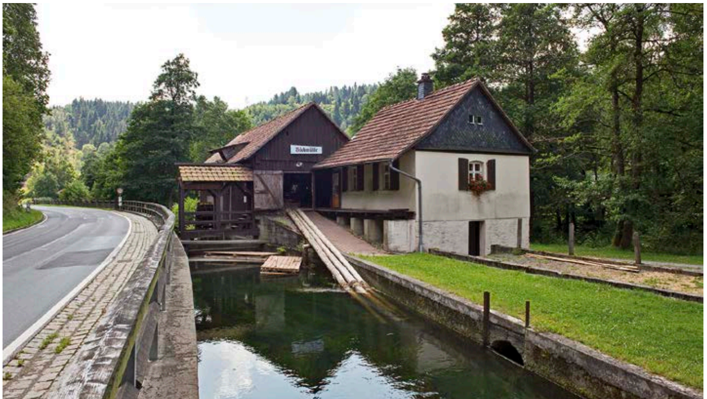
Teichmühle bei Steinwiesen, Lkr. Kronach, mit Mühlgraben (Foto: BLfD, Michael Forstner)
