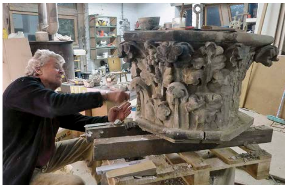
Restaurator Christopher Stark beim Herstellen eines Modells für die Sandsteinkopie des Kapitells (Foto: Christoph Klesse, Steinrestaurierung)
