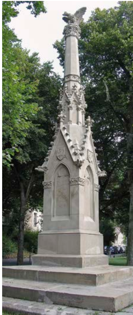
Das Denkmal nach der Restaurierung (Foto: BLfD, Armin Hanson)
