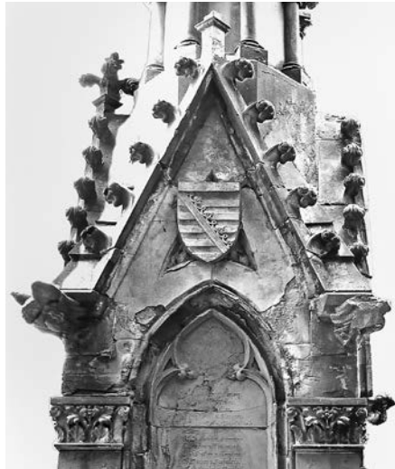
Oberer Teil des Unterbaus, vor der Restaurierung im Sommer 2012 (Foto: ProDenkmal)
