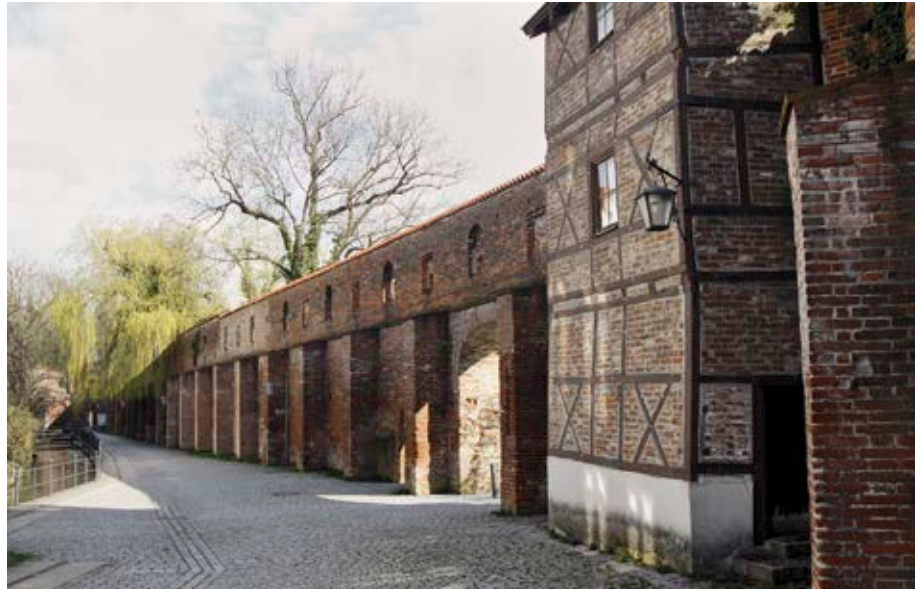
Gut erhaltene Mauerpartie in der Ulmer Vorstadt, um 1465/75, seit 1902 ohne Wehrgang (Foto: Barthel & Maus)
