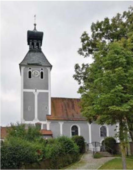
Pfalzpaint, Gde. Walting, Lkr. Eichstätt (Foto: Diözesanbauamt Eichstätt)
