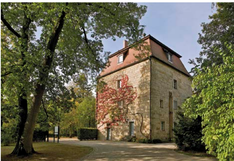
Der ältere Wasserturm beim Alten Schloss (sog. „Brunnenhaus am obern Hain“), errichtet um 1718. Im Dachgeschoss das Reservoir, darunter die ehem. Brunnenmeisterwohnung (Foto: Bayerische Verwaltung der staatlichen Schlösser, Gärten und Seen)
