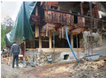
Der Bergbauernhof Dreiwies im Markt Schwarzach, Lkr. Straubing-Bogen, vor und während der Instandsetzung (oben) ... und nach Fertigstellung (rechts) (Fotos: Norbert Bergmann)
