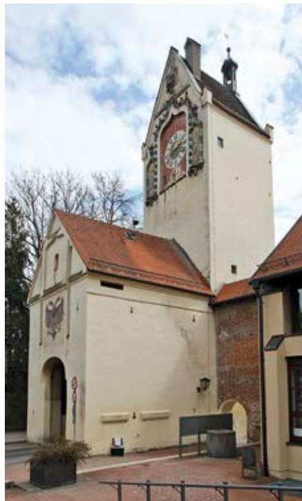
Ulmer Tor, im Wesentlichen nach den Ausbauten des ausgehenden 15. Jahrhunderts mit Aufstockung und Erweiterung um das Vortor (Foto: Barthel & Maus)
