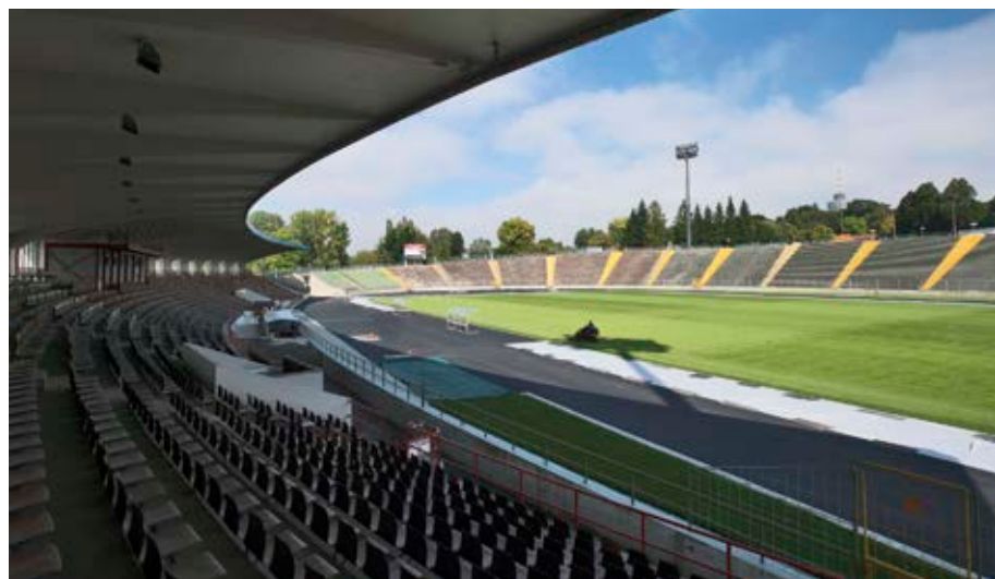
Augsburg. Rosenaustadion, Westseite mit überdachter Stehtribüne (Foto: BLfD, Michael Forstner)
