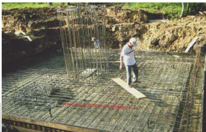
Travaux de préparation du fondement de la borne frontière n° 44 dans la province de Mondoliri-Daklac.
