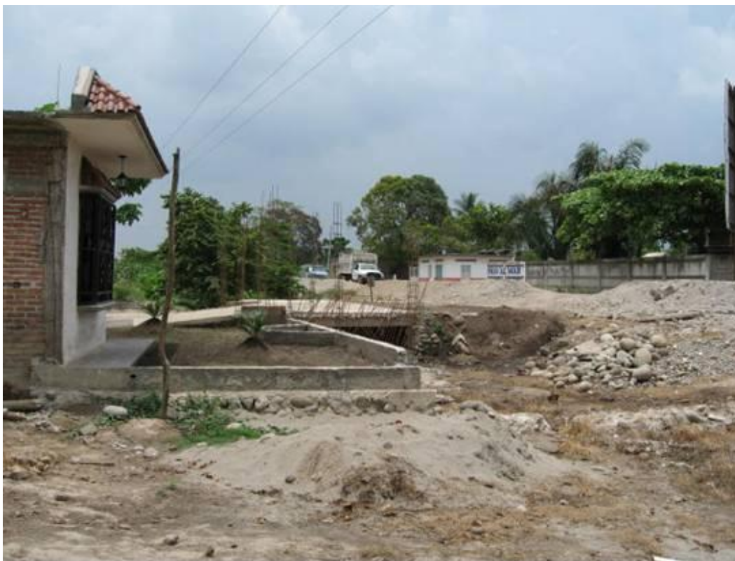
Fotografía 2.17.- Camino a Barra San José, el nivel de agua alcanzó 1.20 cm. El terraplén de la carretera protege a los habitantes del Barrio Guadalupe.
