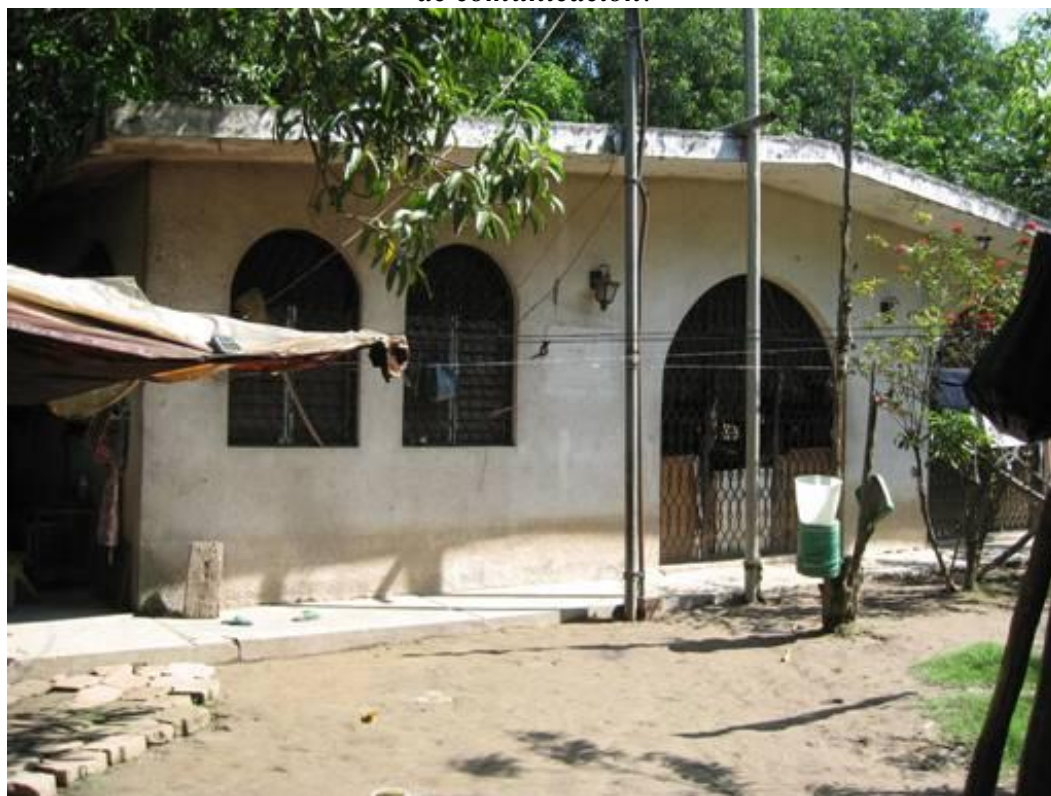
Fotografía 2. 29.- Nótese la marca del nivel de agua y lodo que afectó a viviendas a causa de las inundaciones de octubre de 2005.
