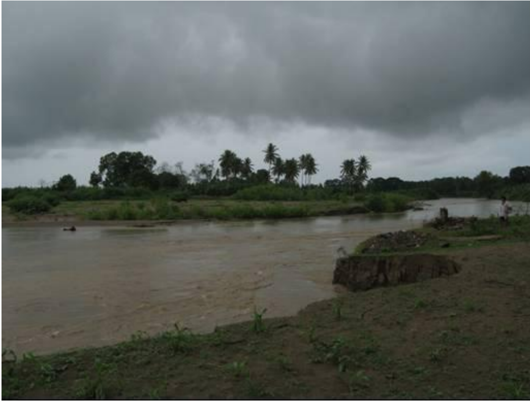
Fotografía 2. 3.- Río Coatán a la altura de la 1ª Sección del Guanacastal, se observa erosión por desbordamiento en las paredes aportando material hacia el cauce y debilitando la margen izquierda este se asocia a deforestación antrópica (Ea2) asociada al crecimiento de la frontera agrícola.
