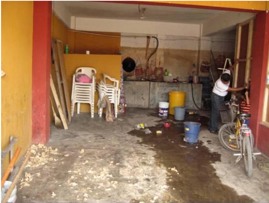
Fotografía 2.10.- Calle del mercado municipal, el nivel de agua máximo registrado es de 1.80m, punto de verificación INMZ010.
