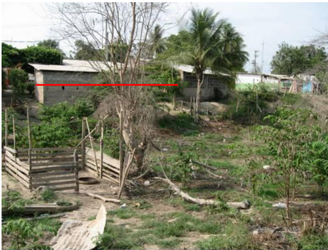
Fotografía 2.19.- Viviendas dentro del cauce del Arroyo Seco, con la línea roja se muestra el nivel de agua y lodo alcanzado.
