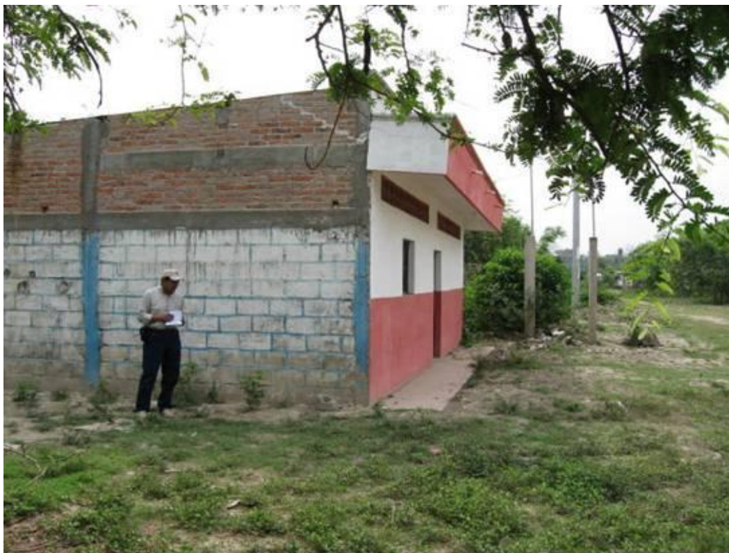
Fotografía 2.18.- Calle Las Flores fraccionamiento Valle Dorado (INMZ041), nivel de inundación 0.8 m.
