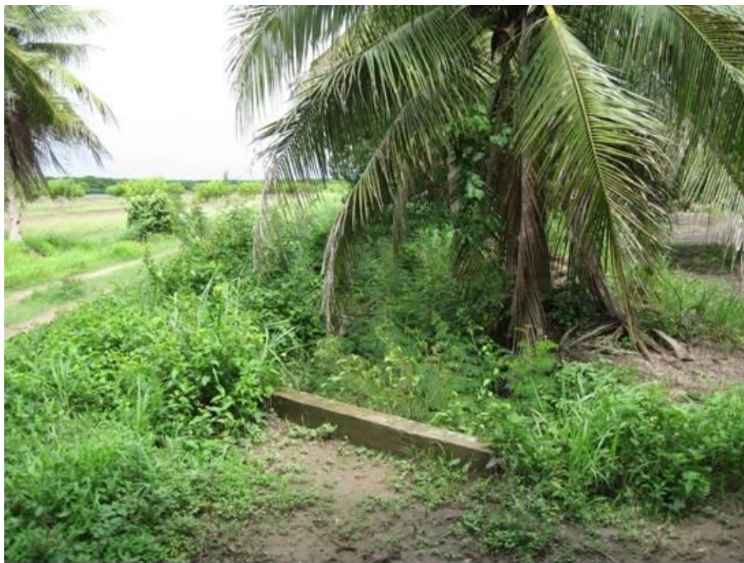
Fotografía 2.24.- Nótese las condiciones que prevalecen en los drenes de la zona, se requiere el desazolve de estos ya que la capacidad de almacenamiento es mínimo.
