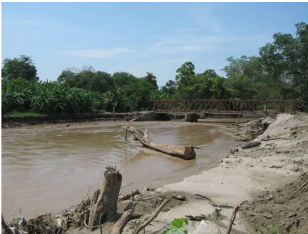
Fotografía 2.32.- Con el incremento de la corriente se puede generar una represa en el puente. Es urgente retirar troncos y basura de los cauces.
