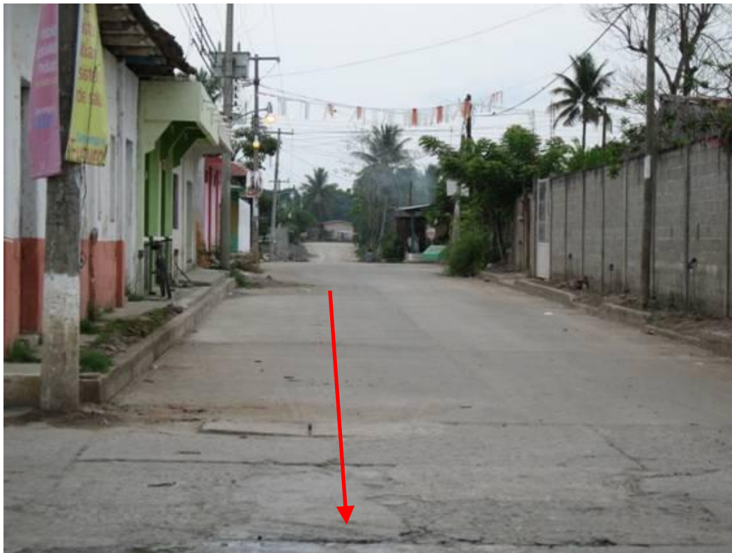
Fotografía 2.14.- Al fondo de la imagen se observa el cauce del arroyo seco, visto de la calle Vicente Guerrero que cruza perpendicularmente, la flecha indica el flujo de agua.
