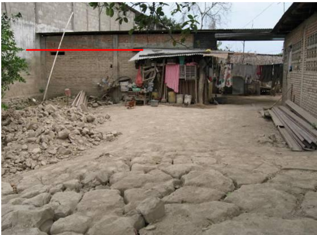
Fotografía 2.7.- Nótese el grado de afectación en las viviendas ubicadas en la Calle Díaz Ordaz esquina con Vicente Guerrero (INMZ039). Zona de alto peligro localizada dentro del Arroyo Seco, nivel de agua y lodo 3 m.
