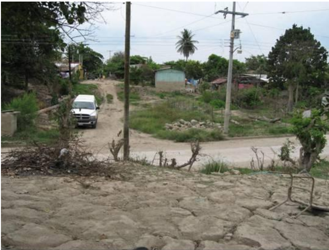
Fotografía 2.1.- Sobre Calle Díaz Ordaz, asentada sobre el cauce del Arroyo Seco se observan hacia la parte inferior de la fotografía, flujos de detritos secos, al centro erosión antrópica asociada a crecimiento urbano (Ea1), erosión hídrica laminar de grado moderado (Eh2) y erosión concentrada a cauces y cañadas (Ec1) y a desbordes.
