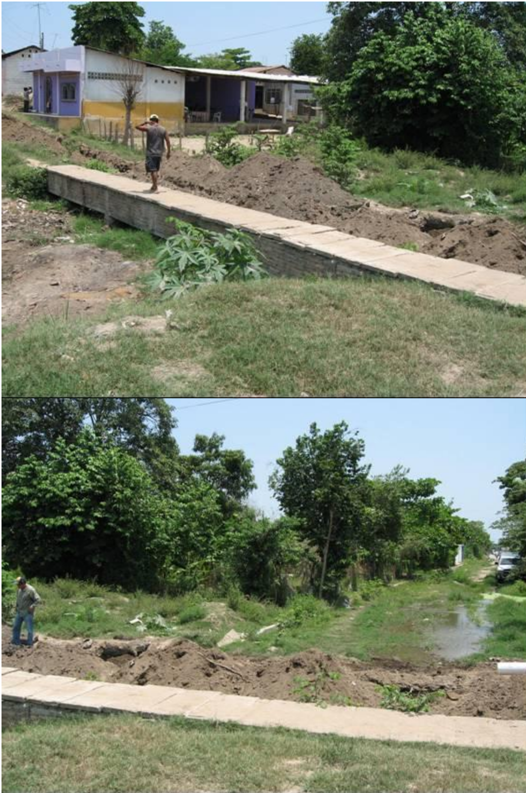
Fotografías 2. 22 y 2.23.- Cauce natural del Arroyo Seco alterado por la actividad del hombre. Se aprecia el nivel de afectación a las viviendas de la zona.
