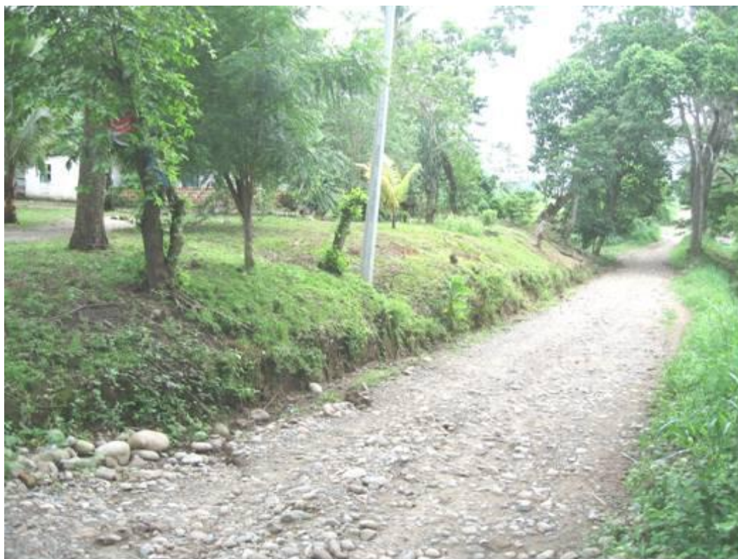
Fotografía 2.30.- Cantón Ojo de Agua, el terreno posee una ligera elevación, mitigando el peligro por inundación.
