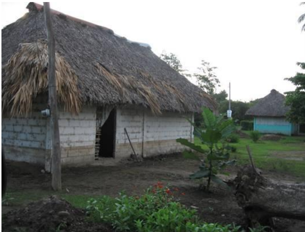
Fotografía 2.38.- Afectaciones en el poblado El Aguacate a consecuencia de las fuertes lluvias originadas por el Huracán Stan.
