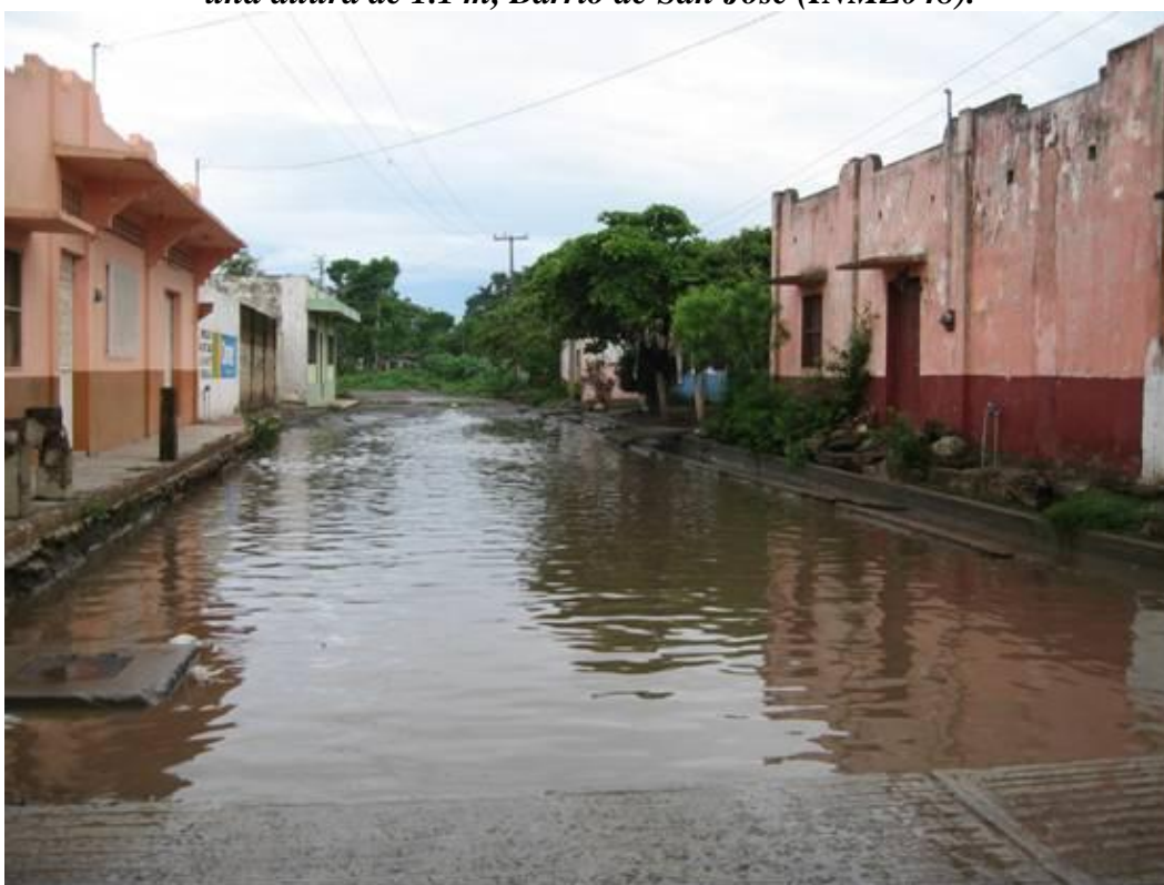
Fotografía 2.16.- Calle Matías de Córdoba, presenta problemas de estancamiento de agua ocasionado por lluvias normales.
