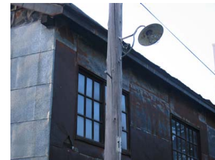
Dゾーンで設置されている街灯
