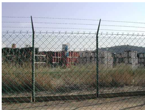
Parc à fûts usine COMURHEX (mai 2003) /
