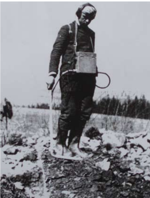
Abb. 2: Soldat des sowjetischen Pionierbataillons Nr. 27305 bei radiometrischen Erkundungsarbeiten auf einer Altbergbauhalde im erzgebirgischen Frohnau im Jahre 1946
