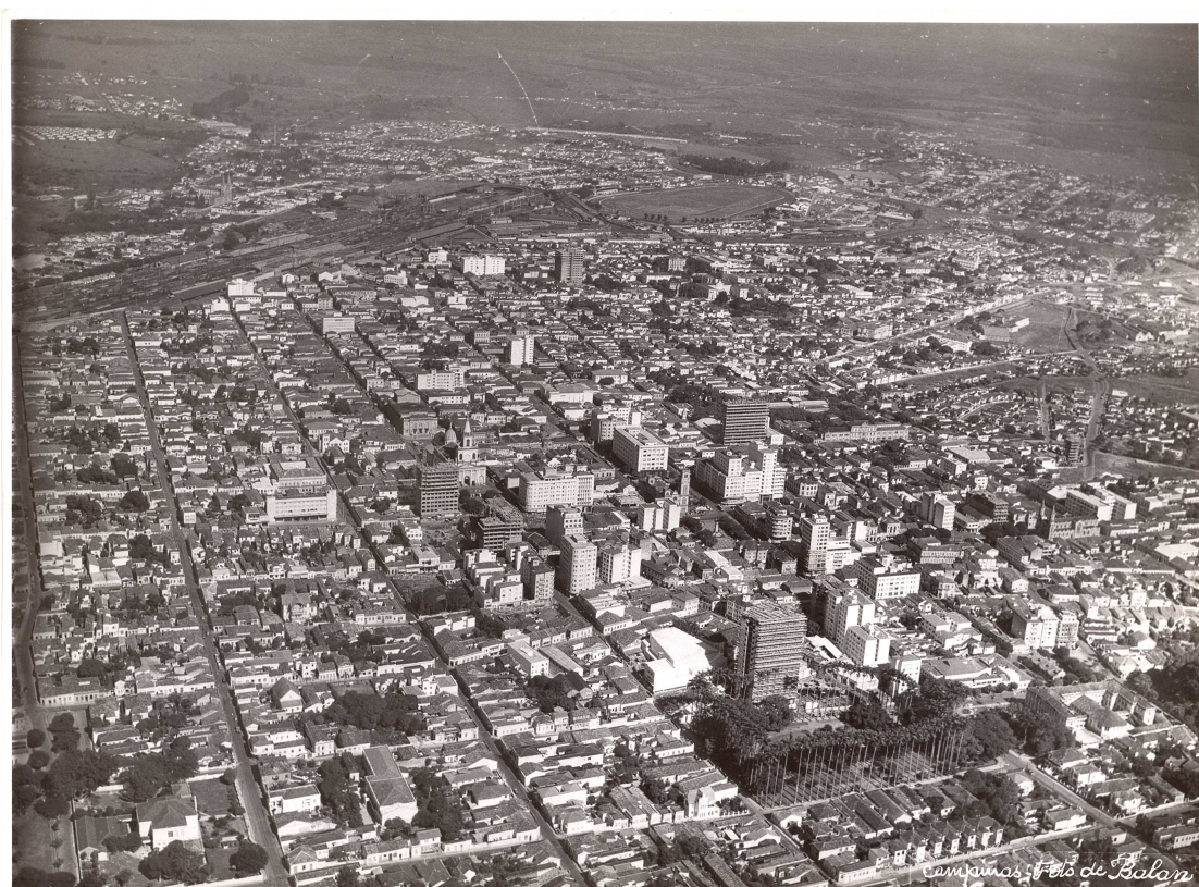
Fig.17– Final da obra do Edifício Itatiaia e sua relação volumétrica com o centro de Campinas.
