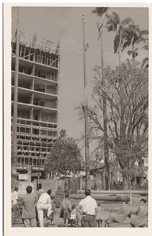
Fig. 16 – Edifício Itatiaia em construção – 1954. Observar lajes tipo caixa perdidas, sem vigas de borda. Fonte: Coleção MIS 1323 – Acervo Museu da Imagem e do Som de Campinas.
