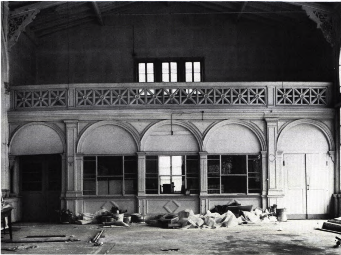
10 BLICK AUF DIE NEBENRÄUME MIT EMPORE.
