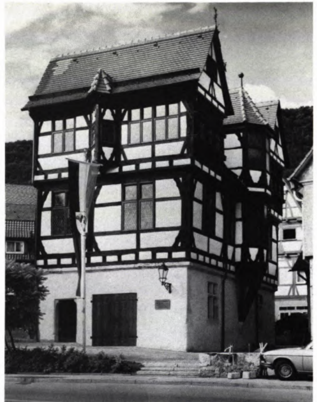
13 ANSICHT VON NORDEN nach der Instandsetzung 1981.
