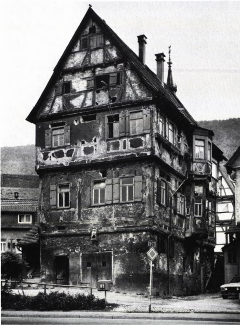
2 DAS HAUS AM GORISBRUNNEN. Ansicht von Norden vor der Instandsetzung 1977. Das Haus zeigt sich als „Bürgerhaus“ mit Giebelausbildung des 16. Jahrhunderts. Längs ist der Ausgang der Außentreppe er- kennbar. Neben dem ursprünglichen Haupt- zugang liegt die Kellertüre.
