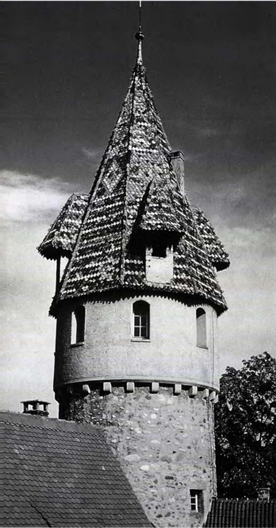
3 Der Grüne Turm vor der Sanierung.
