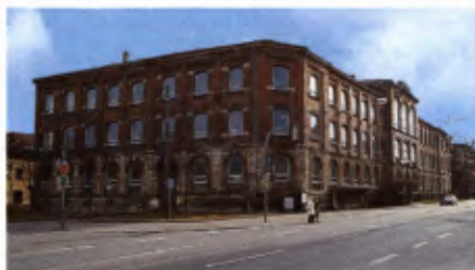
Vom Schulbau zum Tempel der Denkmalpflege: das Schelztorgymnasium in Esslingen.
