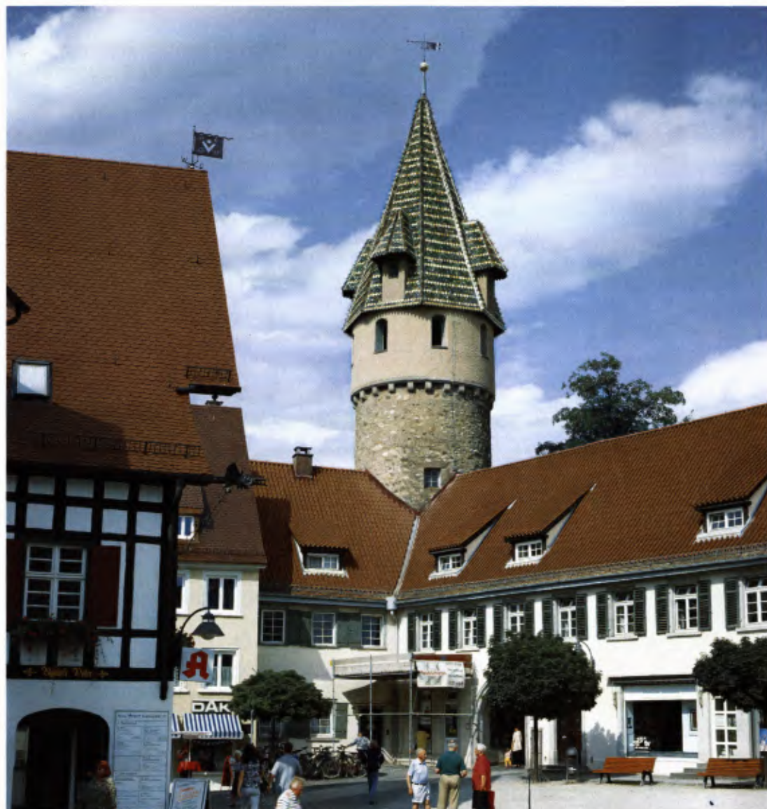
1 Der Grüne Turm in Ravensburg nach Abschluss der Reparatur seiner Dachhaut im Jahr 1998. Blick vom Marktplatz.
