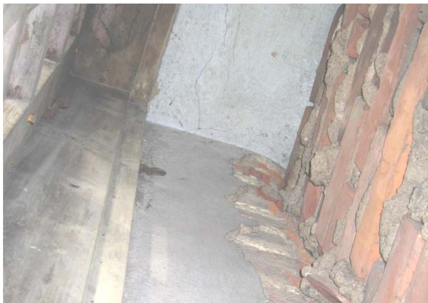
49. Kinnimüritud apsiidi akna-ava. Näha on aknaposti kaardumine.
