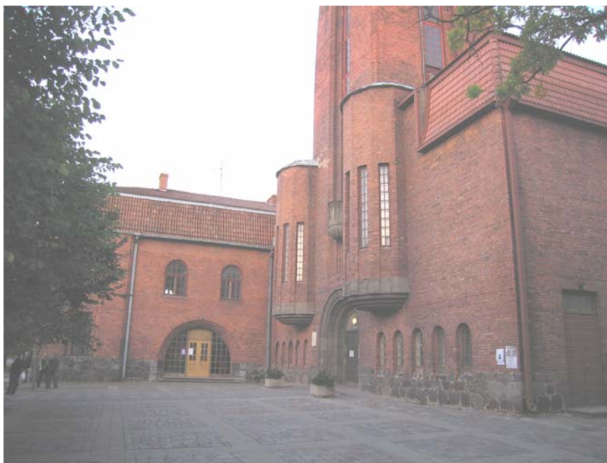
35. Vaade peasissekäigu esisele väljakule. Taga on tiibhoone ja selle peasissepääs.
