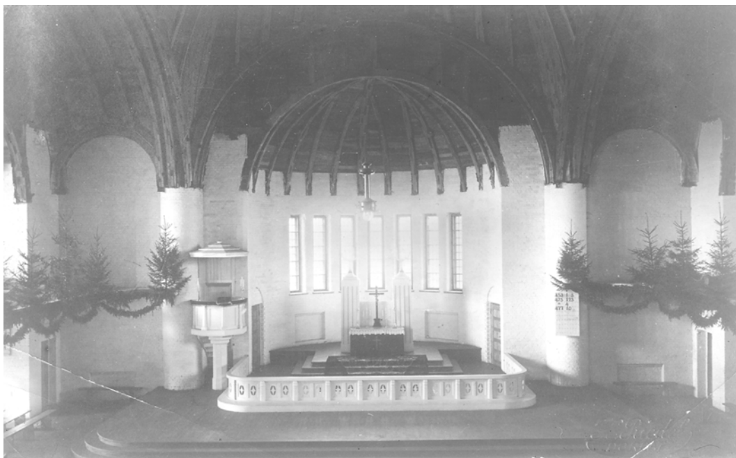
15. Vaade altari suunas pärast esimest pühitsemist oktoobris 1917. Batoon on asendatud puiduga, seinad on veel krohvimata ja rõdud on ehitamata. TPKA.
