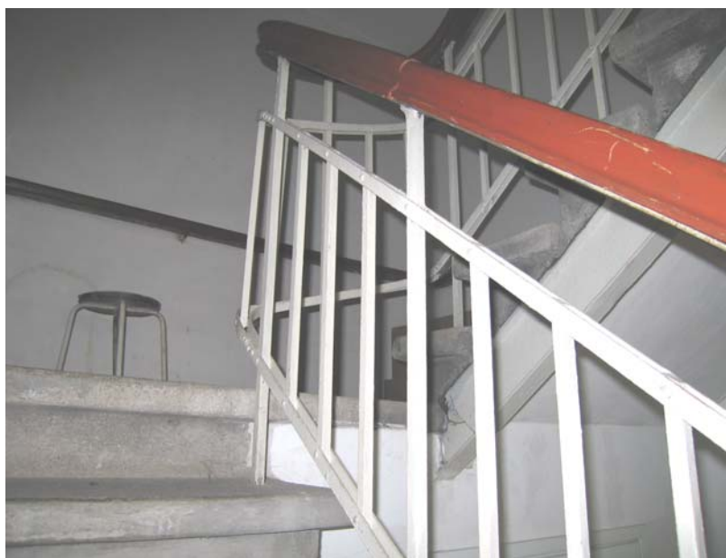
61. Peahoone esikülje kirdetrep astmetala, astmed, piire ja käsipuu.
