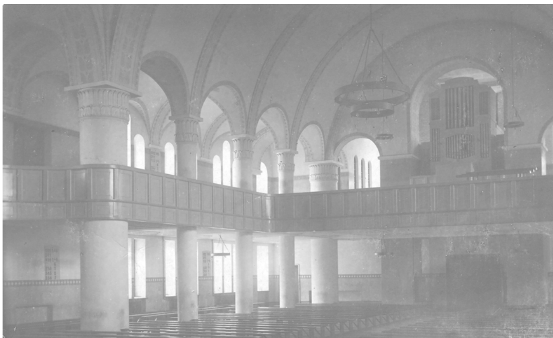
19. Vaade peasissepääsu ja oreli suunas. TPKA.
