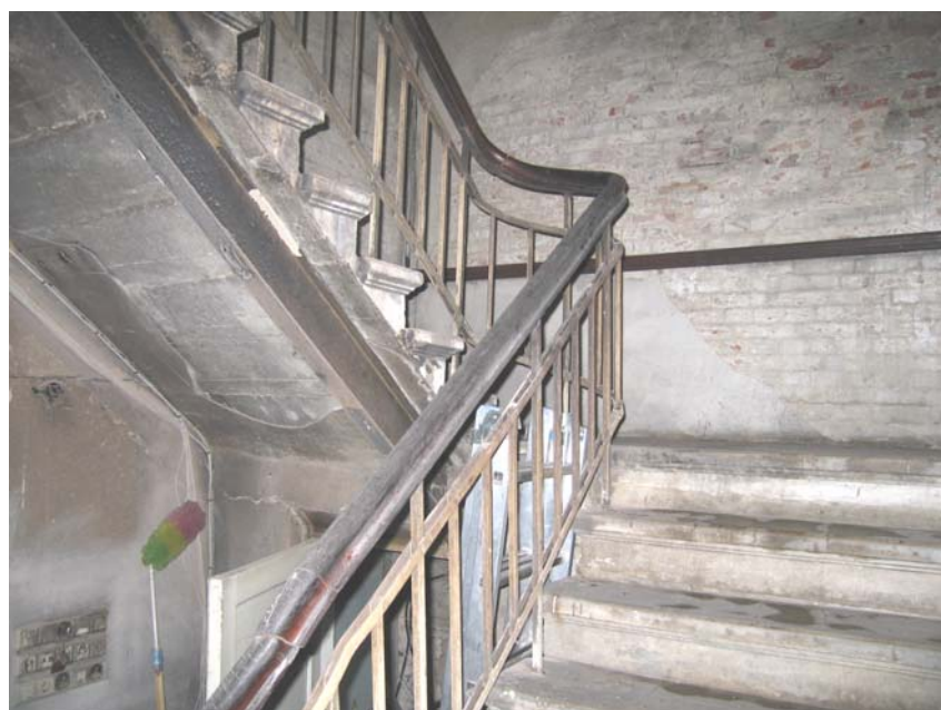
62. Peahoone esikülje edelatrep astmetala, astmed, piire ja käsipuu.
