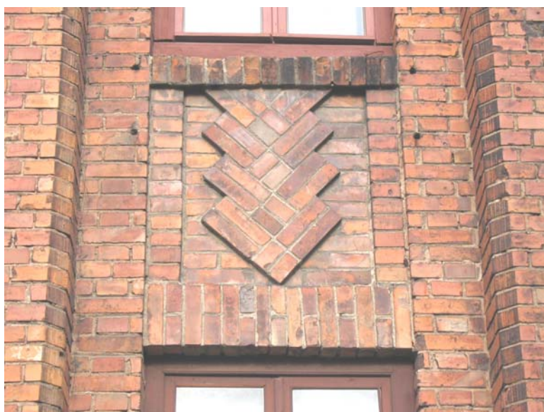
52. Tiibhoone akna vaheväli.
