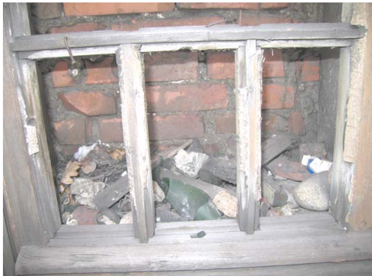
51. Apsiidi akna välisraam ja säilinud prosspulgad.
