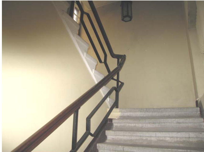
57. Tiibhoone peatrepikoja trepp, selle võre ja käsipuu.
