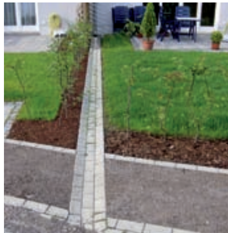
Offene Ableitung des Regenwassers in Welheim
