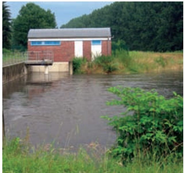
Regenrückhaltebecken bei Hochwasser
