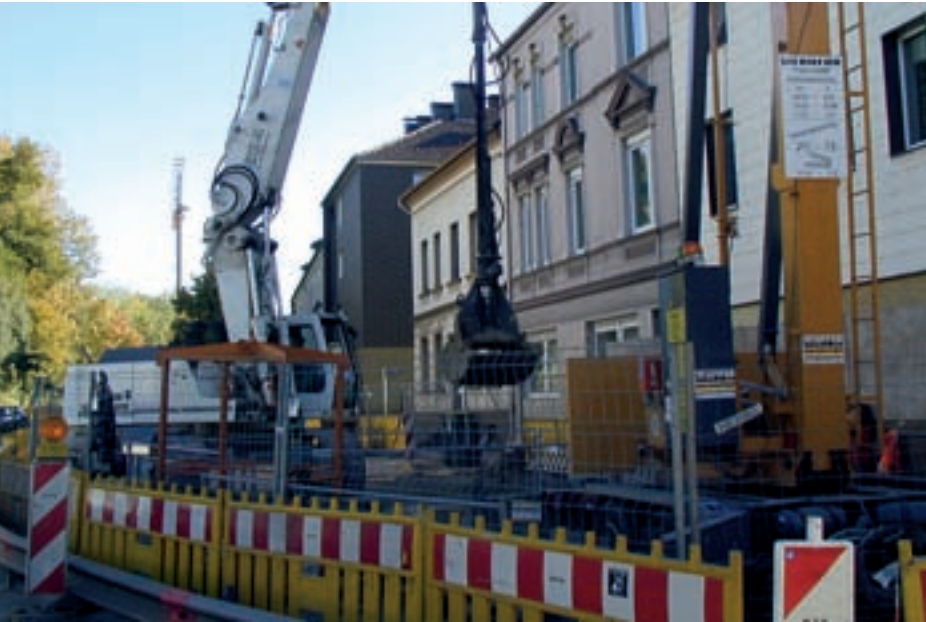
Kanalbau in Hörde
