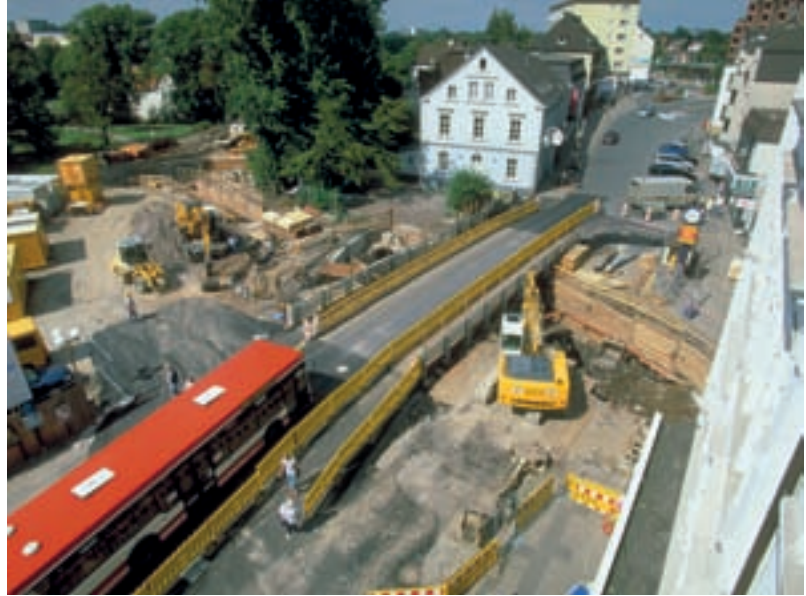
Kanalbau im Ortszentrum von Aplerbeck
