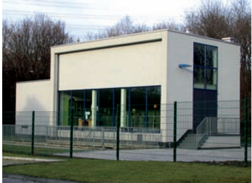
Pumpwerk Bottrop Lehmkuhle
