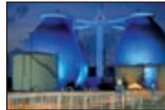
Inbetriebnahme Kläranlage Bottrop
