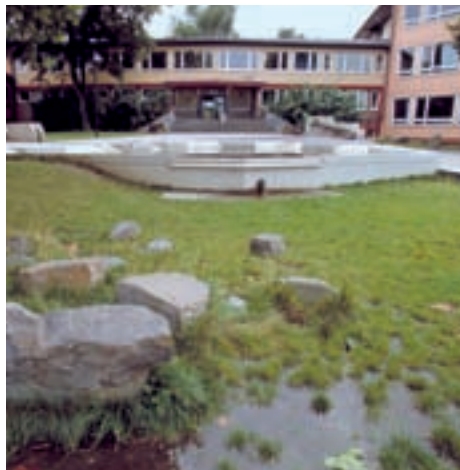
Regenwasserbewirtschaftung an Schulen – hier die Hibernaschule in Herne
