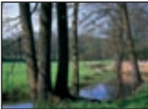
Umbau der Emscher im Westfalenpark zur BUGA
