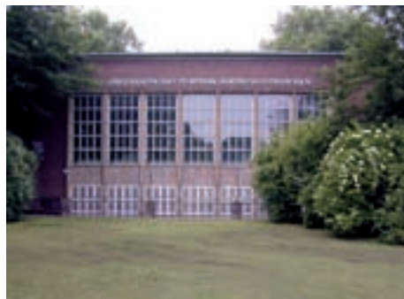
Pumpwerk Dortmund Evinger Bach
