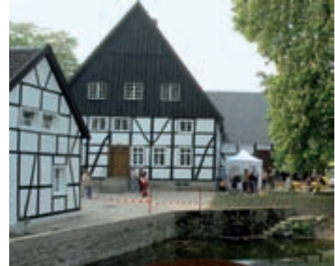
Der Emscherquellhof nach der Restaurierung, Mai 2006
