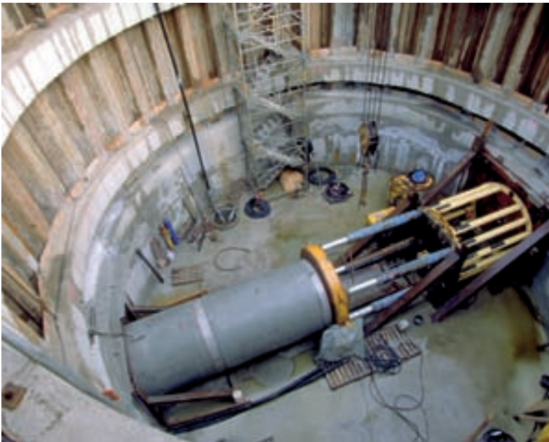
Startschacht des unterirdischen Vortriebsverfahrens
