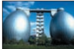
Inbetriebnahme Kläranlage DO-Deusen
