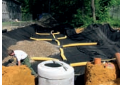
Bau einer Regenwasserrigole
