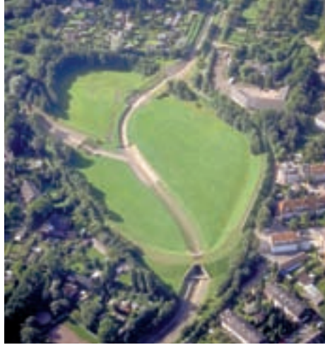
Hochwasserrückhaltebecken am Borbecker Mühlenbach
