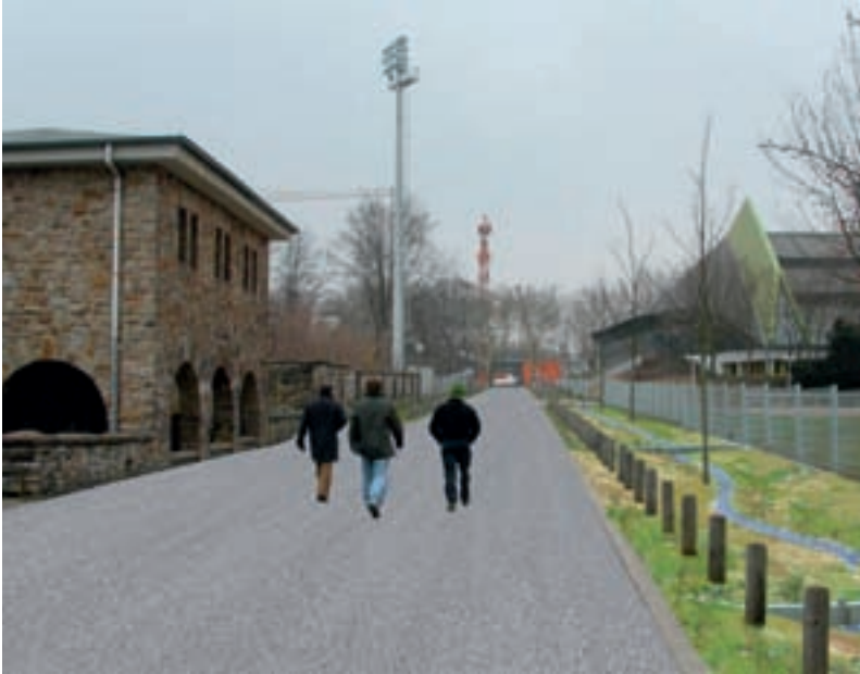
Offene Ableitung von Regenwasser im Umfeld des Westfalenstadions Dortmund
