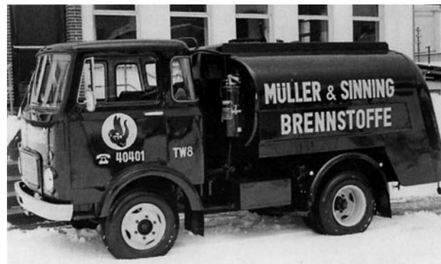
Straßentankwagenaufbau „Helsa ES“ mit ca. 3.600 l Fassungsvermögen. Die Vollschlauchmesseinrichtung Estromatik befindet sich im Kunststoffheckarmaturenschrank.
