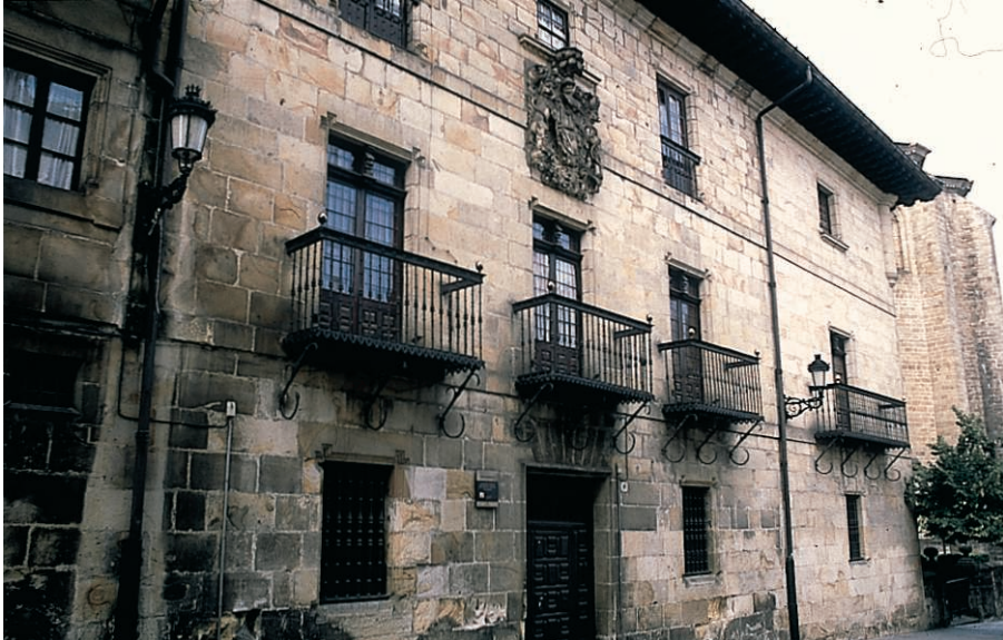
Fachada original del palacio de Casajara o Zearsolo.
