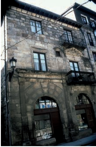
Fachada del palacio de Iburgüen-Urizu, bello ejemplar manierista edificado a mediados del siglo XVI, en el arrabal de Suso .
