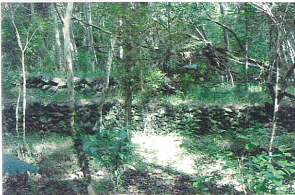
清代溪底營遺址的砌石駁坎。
