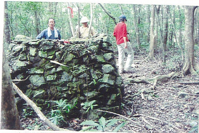
出水坡駐在所的升旗台。
