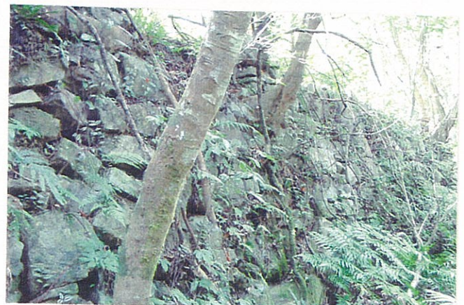
出水坡遺址高3公尺，長達80公尺的基地駁坎。
