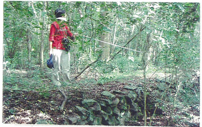
清代溪底營長達 120 公尺的浮築路面。
