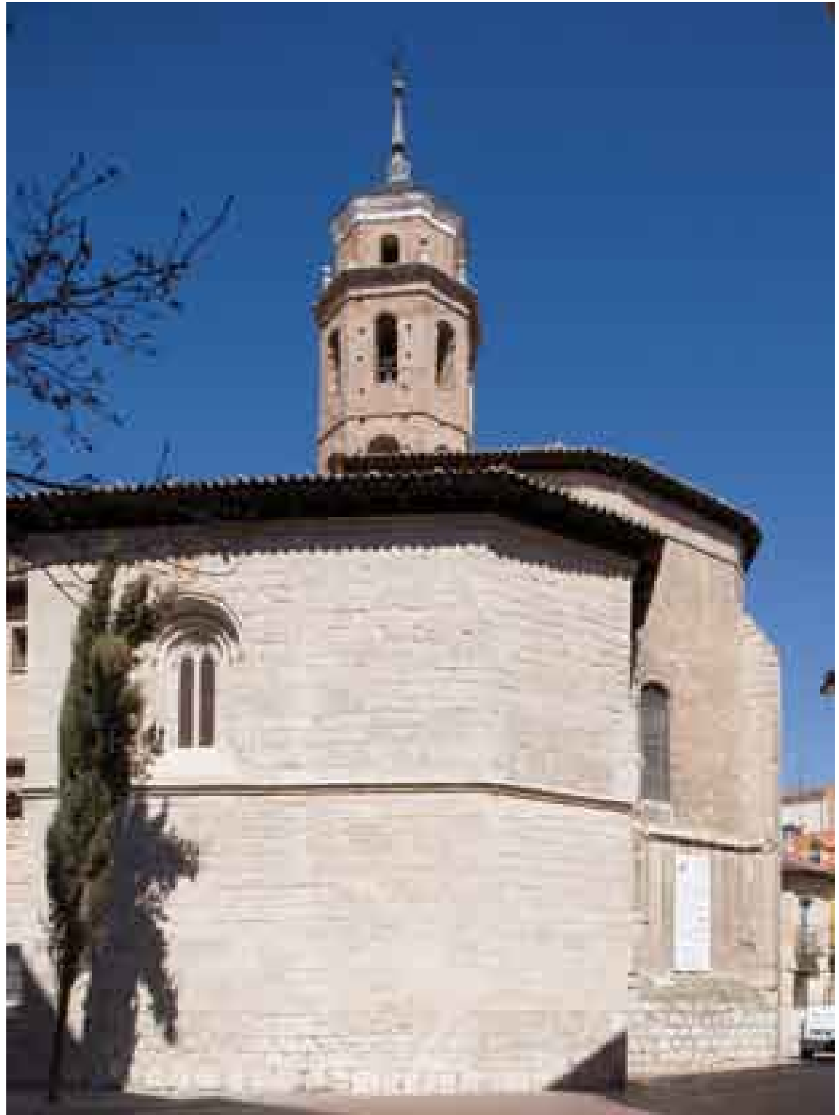
Vista exterior de la capilla después de los trabajos de restauración.
