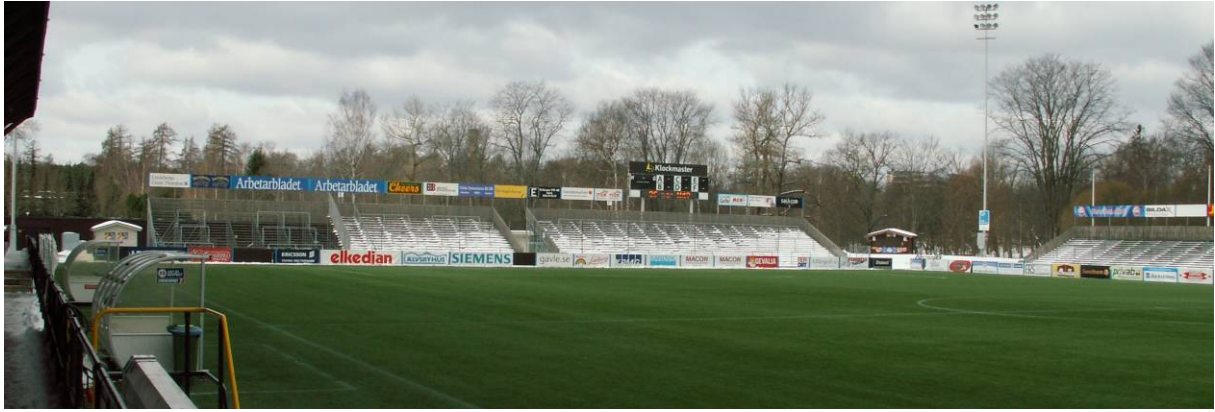
Bild 27. Nya läktare på västra kortsidan.
