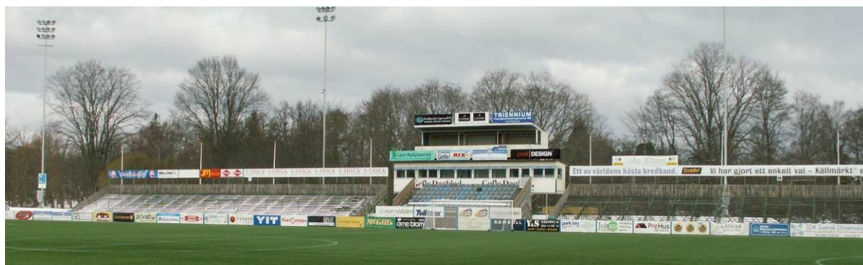
Bild 3. Läktaren på norra långsidan med pressläktare och TV-torn.
