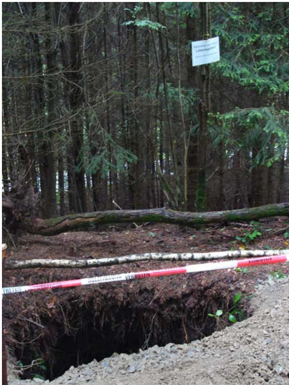
Abb. 11: Tagbruch auf einem Forstweg im Teilrevier Kapellenberg/Kahlberg. Der Bergbau an dieser Stelle war nicht risskundig und zuvor im Gelände kaum noch zu erkennen.
