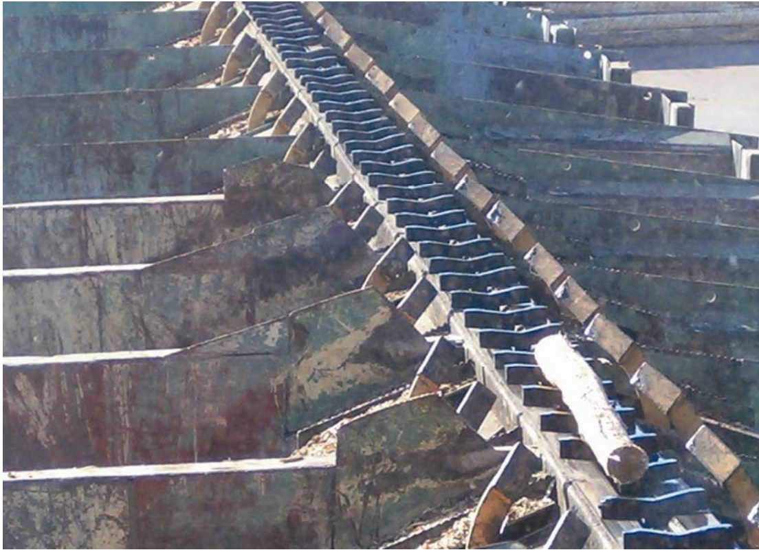
Abb. 16: Sortieranlage in einem modernen Holzwerk.
