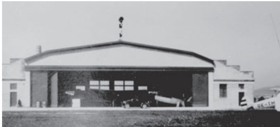
Der „HP-Hangar“ am Flughafen Kottlingbrunn.
