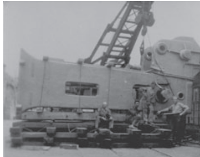
Installation einer neuen 80t-Pressen zur Erzeugung von 8,8 cm Flak-Hülsen im Talwerk 1944.
