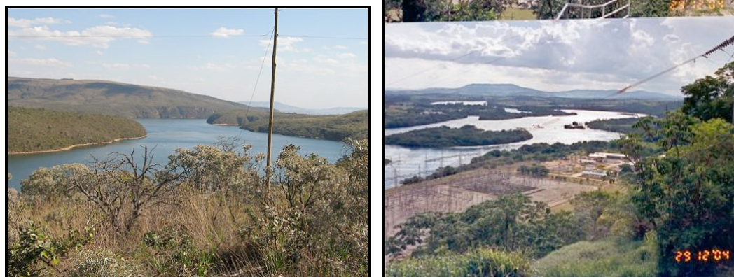
Foto 9 Represa de Furnas no trecho que em 1963 sepultou as gargantas rochosas e corredeiras; julho de 2006 Foto 10 (dupla) acima a casa de força e a subestação elevatória da Usina de Furnas , abaixo a mesma subestação e a vista de jusante do Rio grande, margem direita, município de São João Batista do Glória dezembro de 2004. Fotos Oswaldo Sevá
