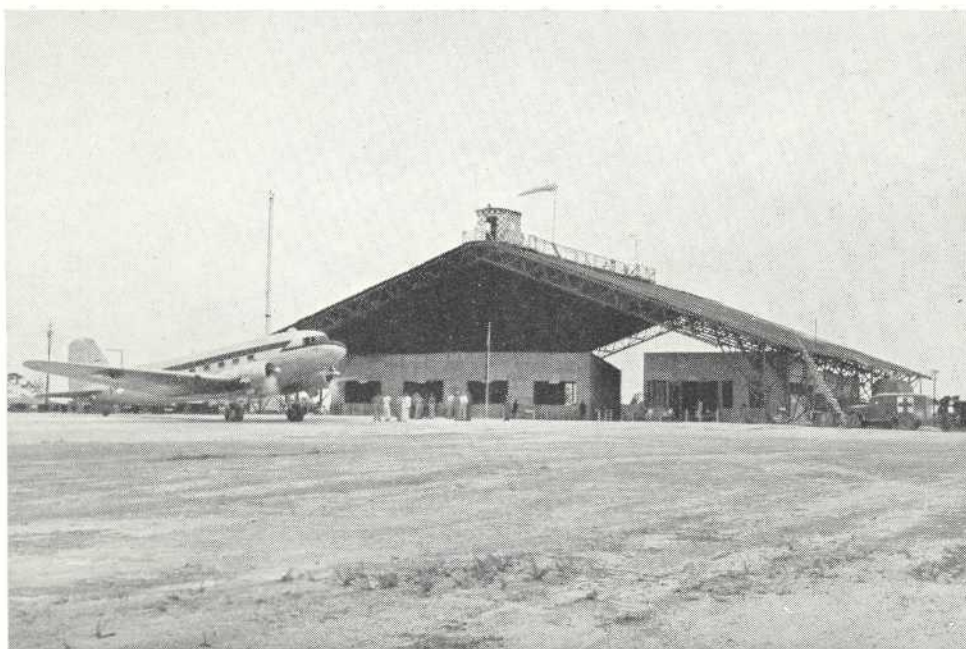
Stationsgebouw van het vliegveld Biak van de Koninklijke Marine. Dakota vliegtuig ernaast. Meteorologische apparaten op de nok van het dak
