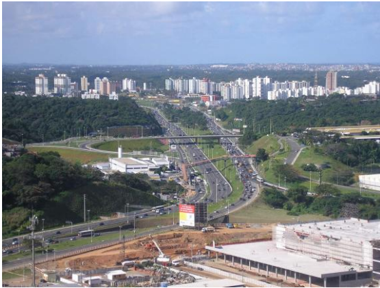
Shopping Salvador em fase de construção Fonte: http://www.skyscrapercity.com/showthread.php?t=386025
