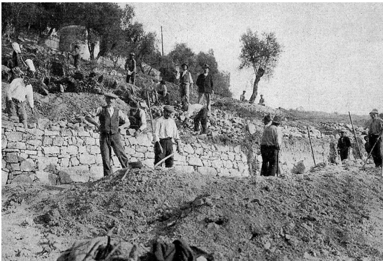
Lavori di sistemazione montana: costruzione di mura e formazioni di terrazzi
