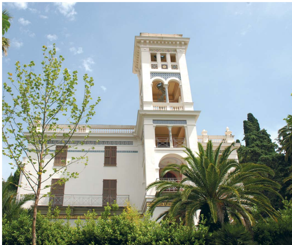
Nelle foto, veduta della villa e particolare dell'iscrizione con dedica al nobile tedesco che ne fu il proprietario.
