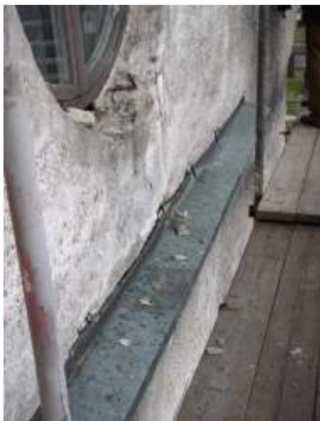
T.v. befintlig plåtavtäckning i överkant av nykyrkans portal. Hela plåten togs bort då infästningen var undermålig och vatten kunde tränga in bakom plåten. T. h. ny plåtavtäckning med putsbärande kant och nedbockad fram- och sidokant.
