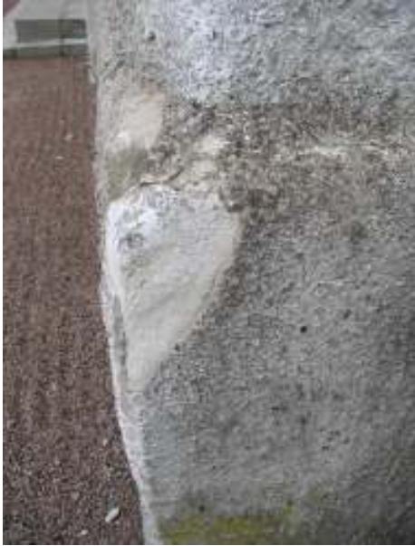
Putsskador på nykyrkan. T.v. visandes en skada på nykyrkans hörn samt den nedsmutsning av framförallt alger som fasaderna bade. T.h. visandes skada vid ett av fönstren orsakat av inträngande fukt vid infästningen av en hantverksmässigt undermålig plåtavtäckning.
