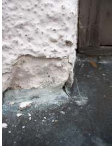
Putsskador på nykyrkan. T.v. visandes en skada på nykyrkans hörn samt den nedsmutsning av framförallt alger som fasaderna bade. T.h. visandes skada vid ett av fönstren orsakat av inträngande fukt vid infästningen av en hantverksmässigt undermålig plåtavtäckning.
