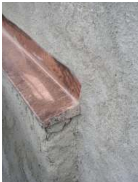
T.v. befintlig plåtavtäckning i överkant av nykyrkans portal. Hela plåten togs bort då infästningen var undermålig och vatten kunde tränga in bakom plåten. T. h. ny plåtavtäckning med putsbärande kant och nedbockad fram- och sidokant.
