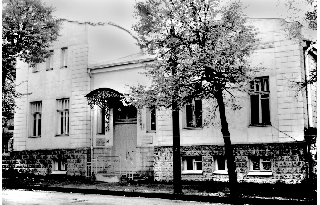
Сумський окружний відділ ДПУ УСРР. Тепер у цьому будинку обласний протитуберкульозний диспансер. Вул. Перекопська, 15. Фото І. Ройченка. 2006 р.
