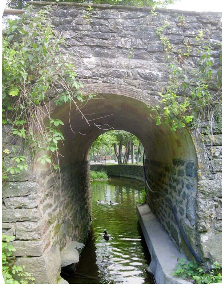
Fig. 10. Pont sobre el torrent Mal a la zona de les Eres.
