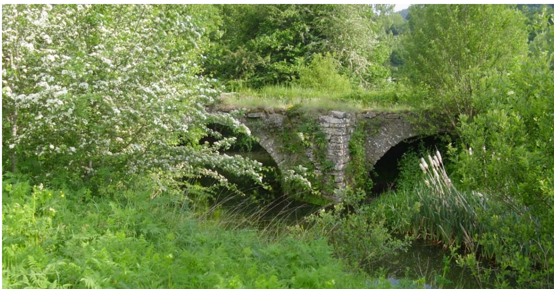
Fig. 13. Pont de la Sala sobre la riera de Rupit a camí rural.
