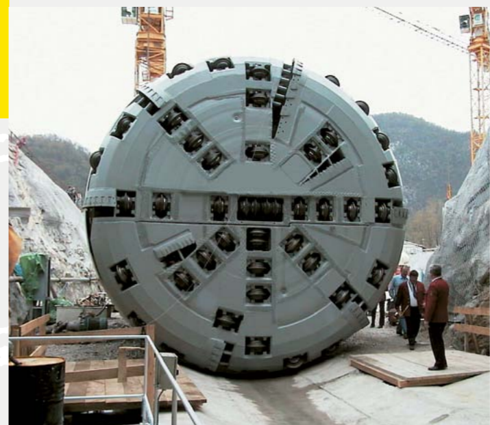
Vrtlalni stroj TBM (tunnel boring machine)
