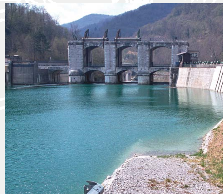
Akumulacija Ajba sistema HE Plave služi tudi kot spodnji bazen ČHE Avče
