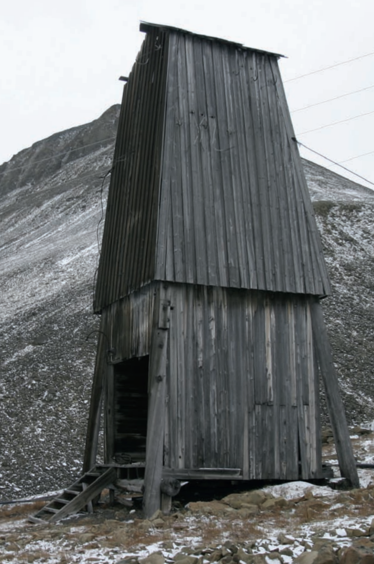
Trafohuset er Sveas eldste bygning. Foto: Store Norske
