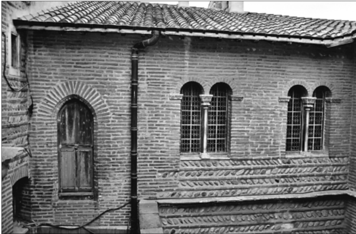
FIG. 20. SECOND ÉTAGE DU CORPS-ARRIÈRE. Élévation sur cour. Cliché Frédéric Messager, HADÈS.
