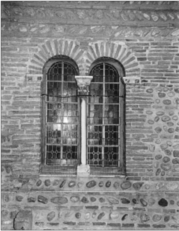
FIG. 23. DÉTAIL D'UNE BAIE GÉMINÉE. Impostes refaites. Cliché Frédéric Messager, HADÈS.
