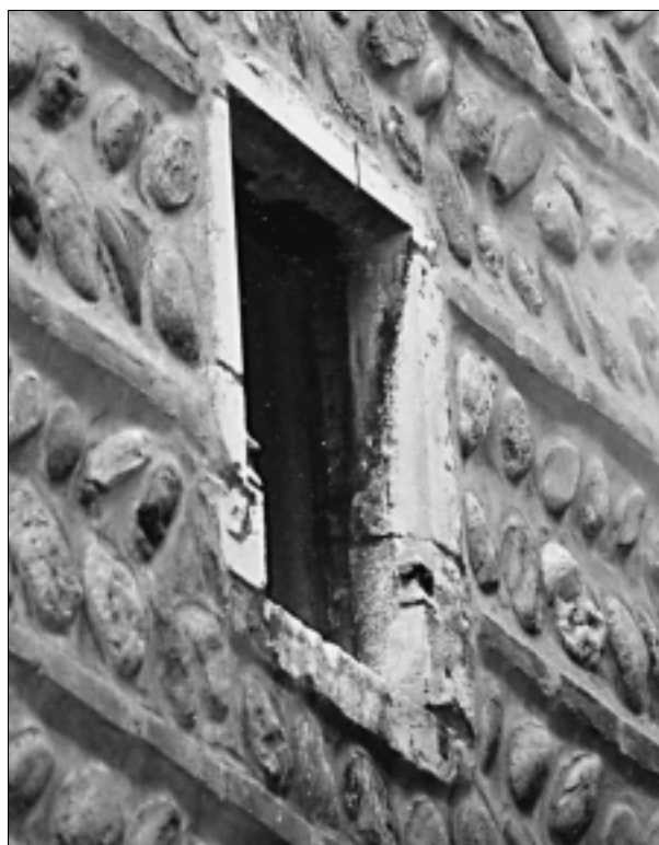
FIG. 17. LA SALLE. Fenestron sud. Cliché Frédéric Messager, HADÈS.
