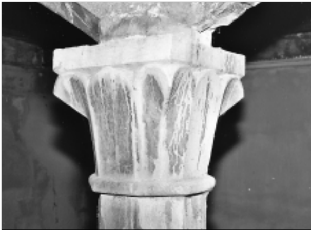
FIG. 30. ARCADES DU REZ-DE-CHAUSSÉE. Chapiteau. Cliché Frédéric Messager, HADÈS.
