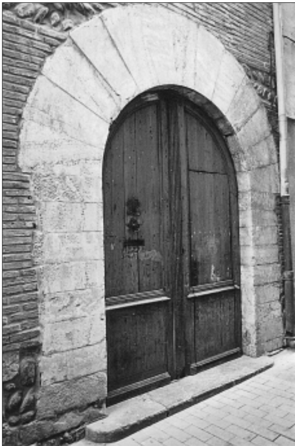
FIG. 9. PORTAIL D'ENTRÉE. Rue Fabriques den Nabot. Cliché Frédéric Messager, HADÈS.
