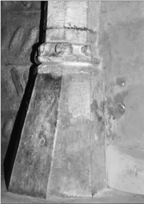
FIG. 31. ARCADES DU REZ-DE-CHAUSSÉE. Base sud-est. Cliché Sandrine Conan, HADÈS.
