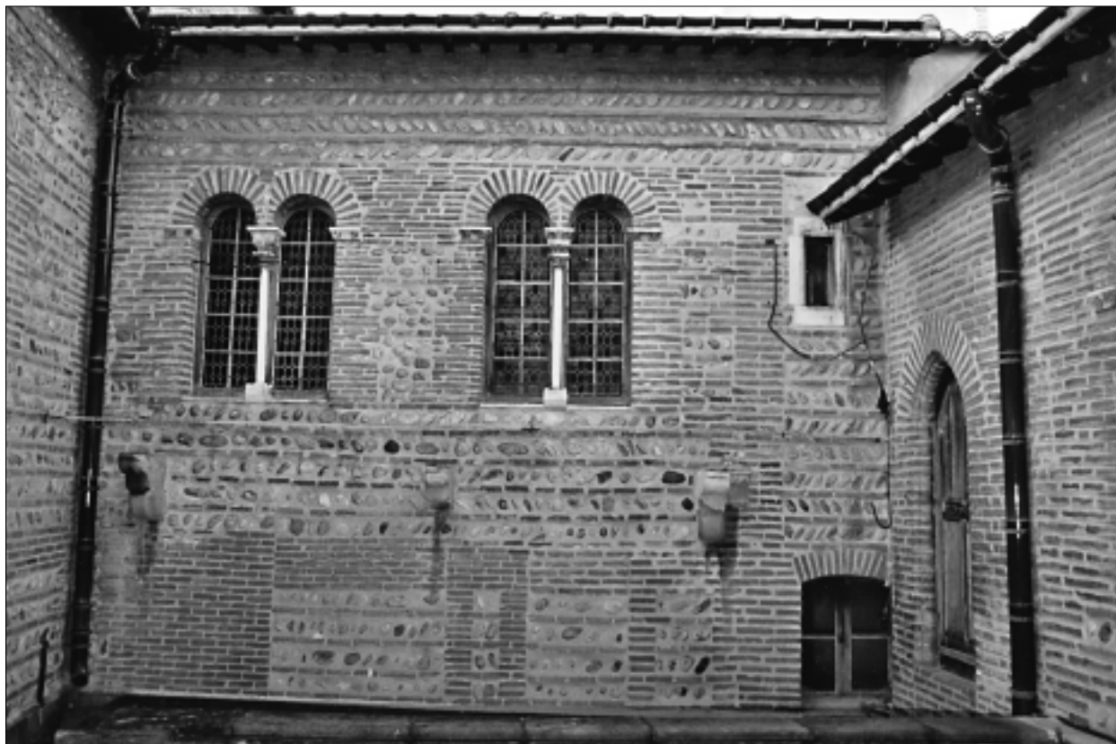
FIG. 22. SECOND ÉTAGE. Élévation sur cour de la partie nord-est du bâtiment principal. Cliché Frédéric Messager, HADÈS.
