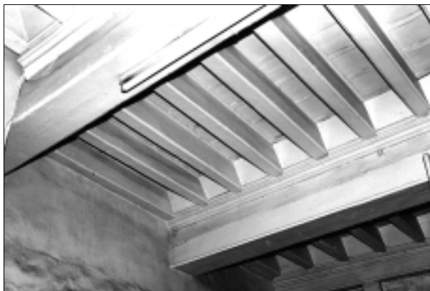
FIG. 24. PLAFOND DU REZ-DE-CHAUSSÉE DU CORPS-ARRIÈRE. Détail. Cliché Frédéric Messager, HADÈS.
