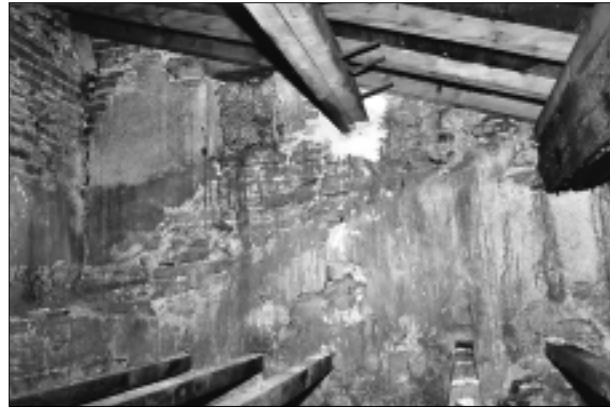
FIG. 19. DEUXIÈME ÉTAGE DU CORPS-ARRIÈRE (B). Mur sud avec les restes de l'enduit qui indiquent le tracé de la charpente apparente. Cliché Frédéric Messager, HADÈS.
