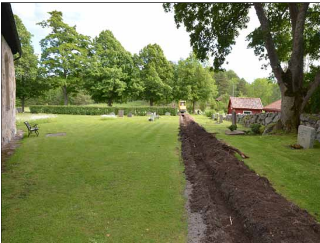
8 Schakt 3 från väster (Slm D12-0663).
