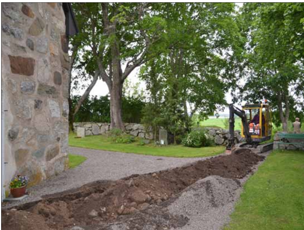
7 Schakt 1 från norr (Slm D12-0662).
