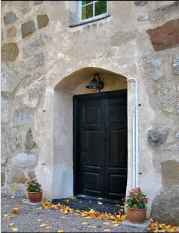
11 Köldbärarledningen drogs in kyrkan via en ventilationskanal i dörröppningens norra smyg (Slm D12-0666).
