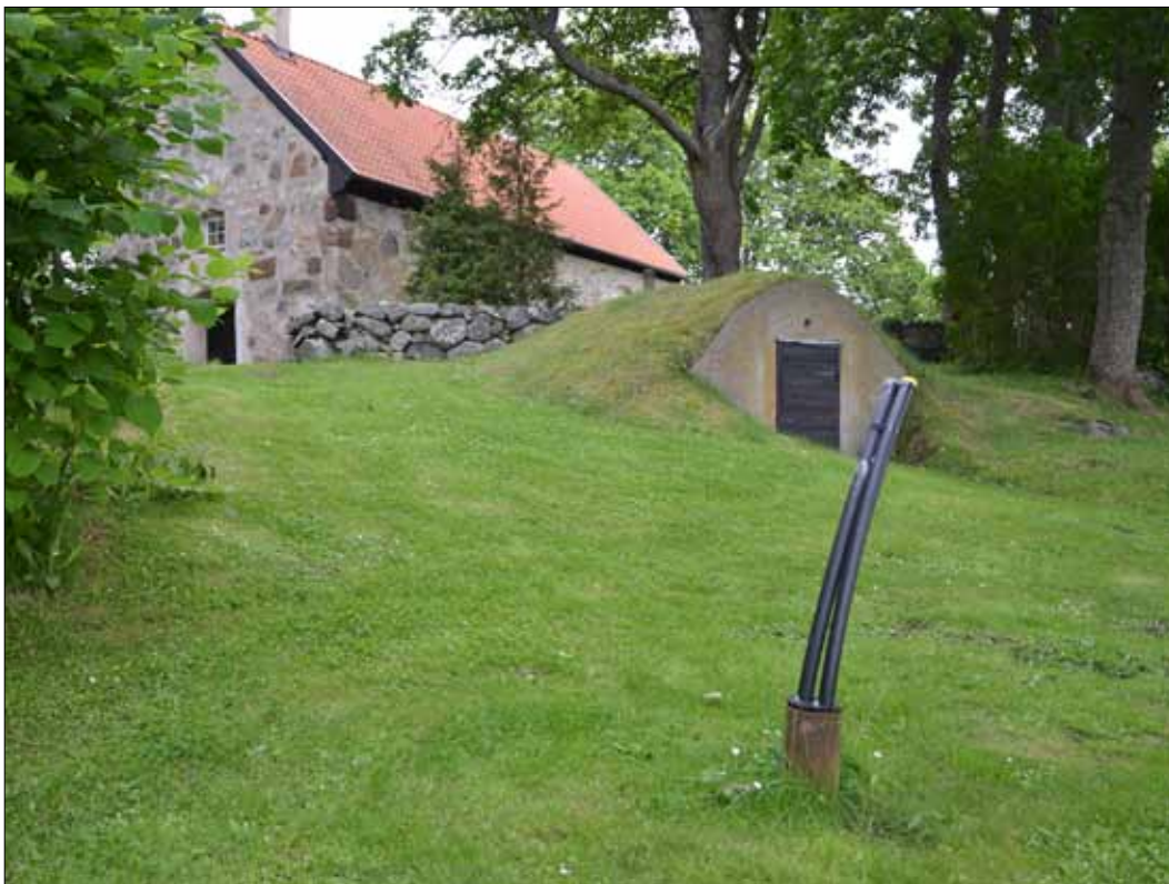
4 Gräsytan mellan kyrkogården och energibrunnen från sydväst före påbörjad schaktning (Slm D12-0659).
