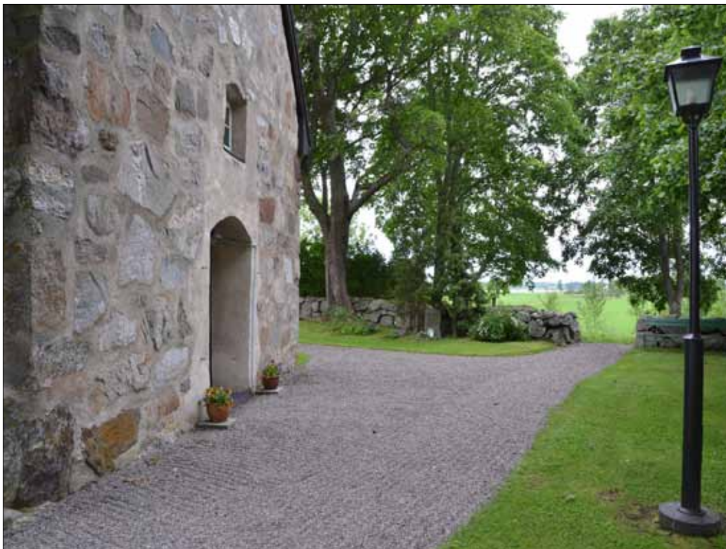
6 Ytan framför kyrkans huvudingång före påbörjad schaktning (Slm D12-0661).
