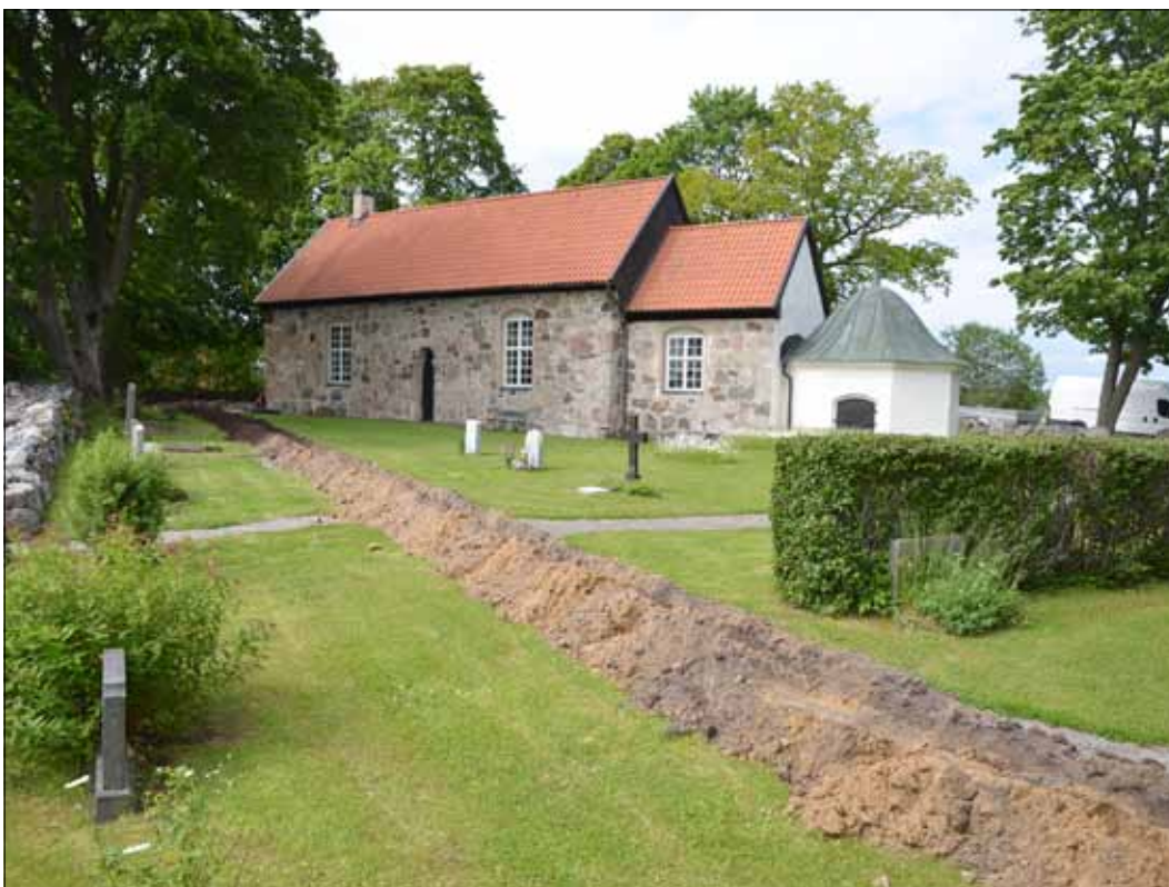
9 Schakt 3 från sydost (Slm D12-0664).
