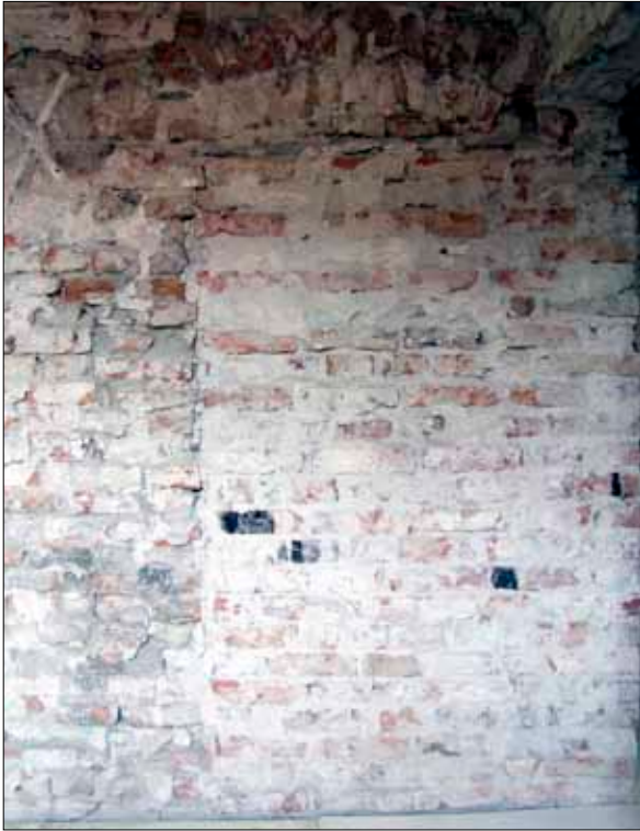
97 Igenmurad dörröppning mot trapphuset från öster, 20070927 (Slm D09-738).
