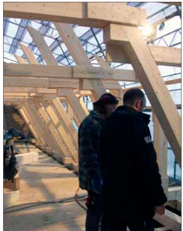
108 Rum 301 efter uppsättning av nya takstolar, 20071207. Foto: Magnus Josephson, Sörmlands museum (Slm D09-915).
