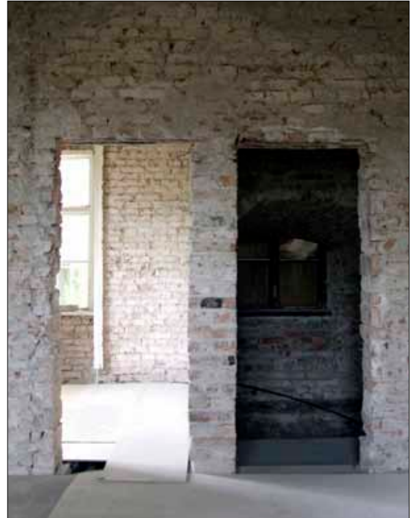
92 Dörröppningarna mot rum 201, t h, och rum 209, t v, 20070927 (Slm D09-734).
