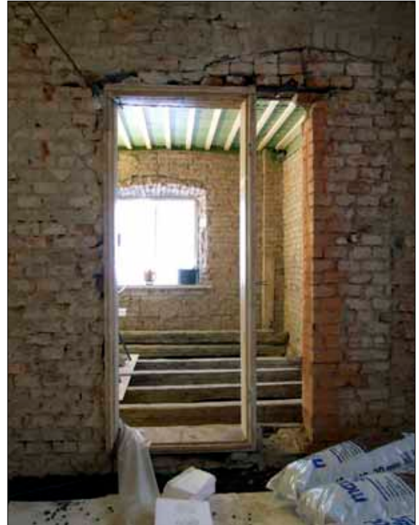
36 Dörröppning mellan rum 103 och 104 efter flyttning av dörrkarmen åt söder, från öster, 20080207 (D09-686).
