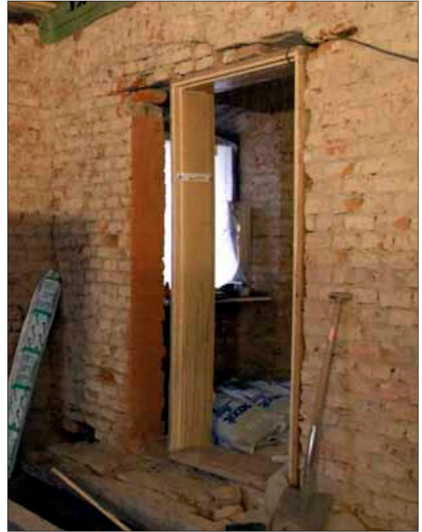
28 Dörröppningen mellan rum 103 och 104 från sydväst, 20080207 (Slm D09-679).
