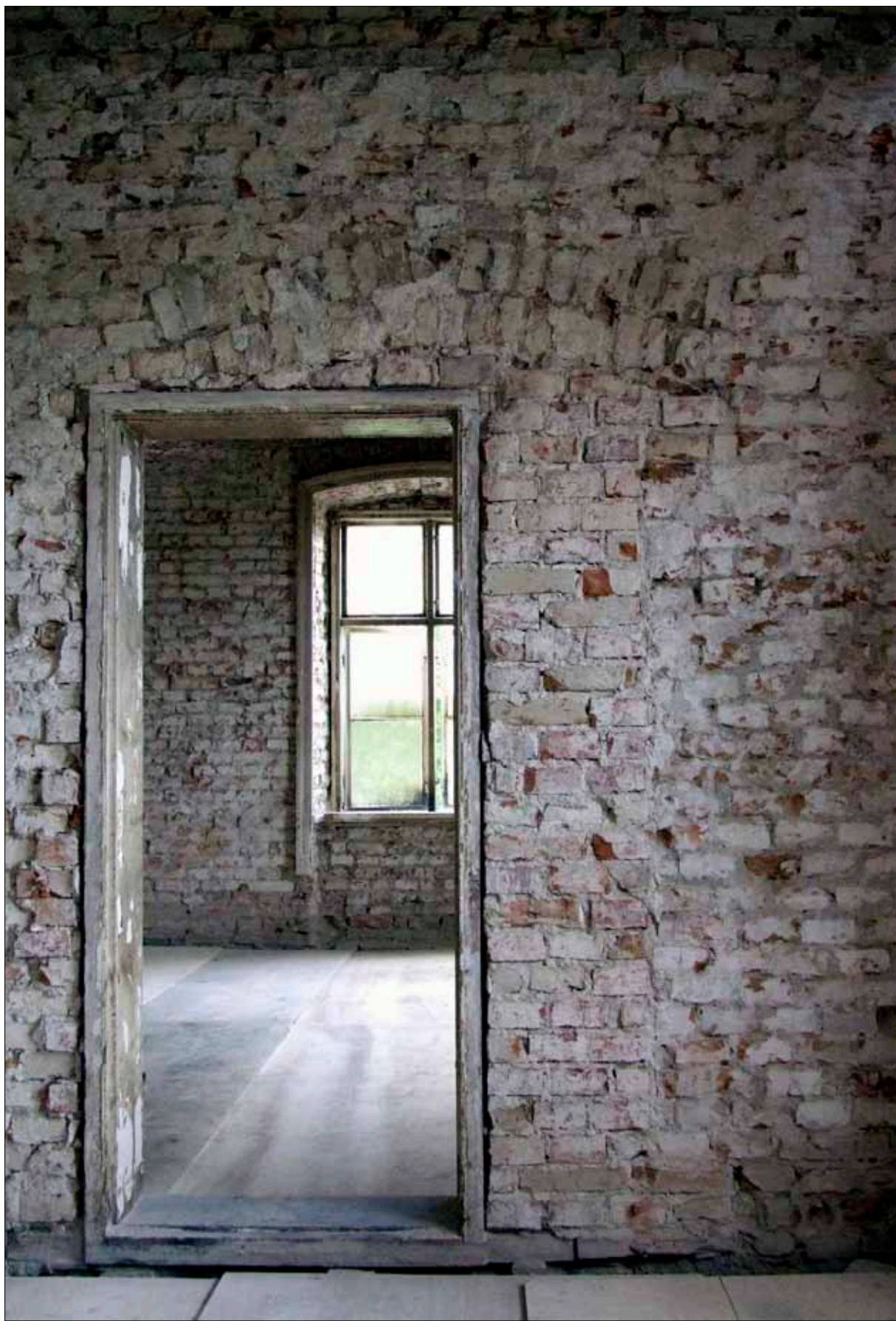
109 Dörröppningen mellan rum 204 och 205 från öster, 20070927 (Slm D09-916).
