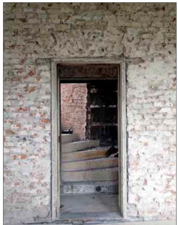
85 Dörröppning mot rum 201 från norr, 20070927 (Slm D09-728).
