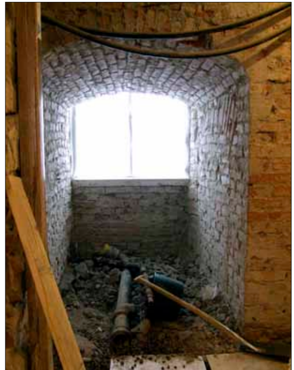
51 Öppningen mellan rum 107 och 108 från norr, efter borttagning av dörrkarm, 20080207 (Slm D09-699).
