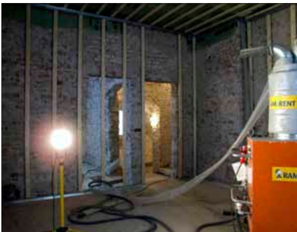
91 Dörröppningarna mot rum 201 och rum 209 från nordväst, 20080207 (Slm D09-733).
