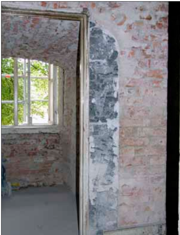
49 Dörröppningen mellan rum 107 och 108 från norr, 20070927 (Slm D09-697).
