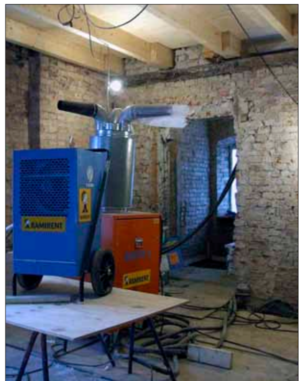
52 Dörröppningen mellan rum 109 och 110 från nordväst, 20080207 (Slm D09-692).
