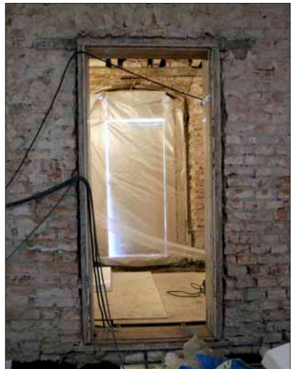
37 Dörröppningen mellan rum 101 och 104 från söder, 20080207 (D09-687).
