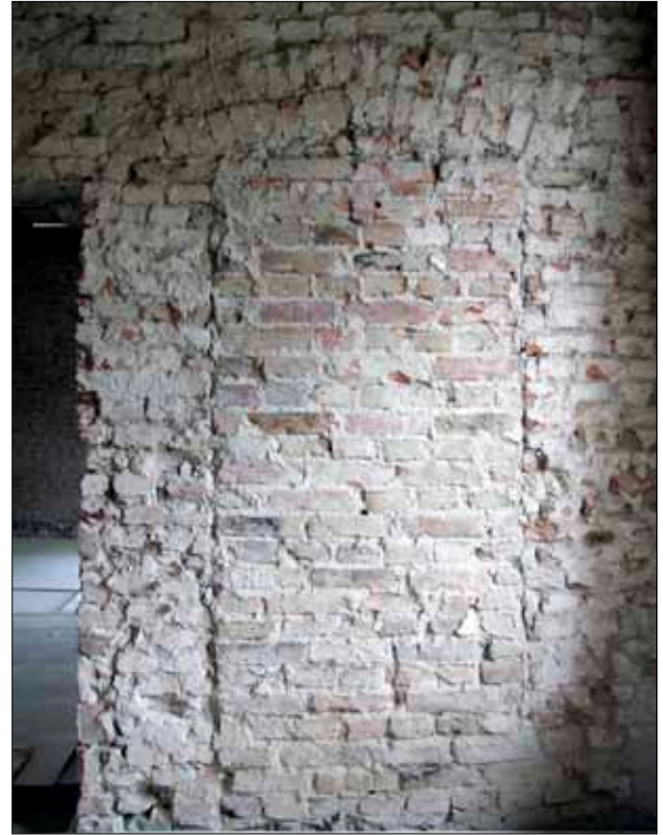
99 Igenmurad dörröppning mot rum 208 från söder, 20070927 (Slm D09-740).
