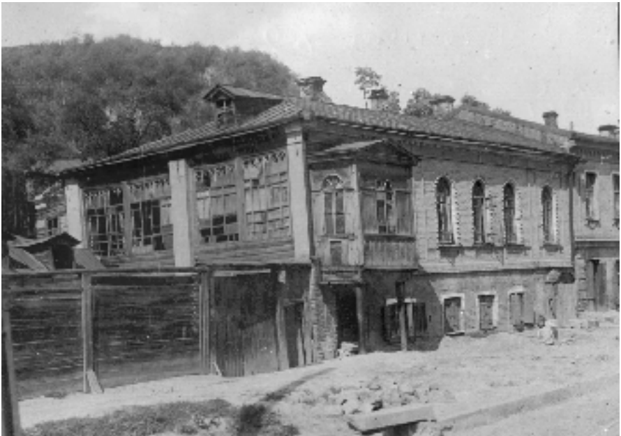
12. Глибочиця, 89. Будинок купця (90-ті рр. XIX ст.)
