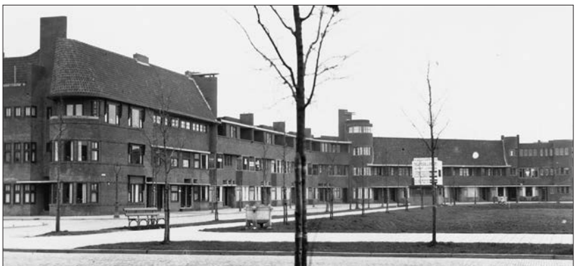
Afb. 4. Bernoulliplein, kort na oplevering, circa 1930. De bouwkeet gaat schuil achter het bouwbord. Foto: P.B. Kramer, collectie Groninger Archieven.
