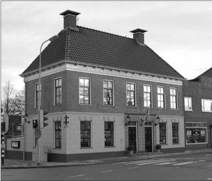
Afb. 16. Hoendiep 212, na herstel. Foto: Jaap Buist.
