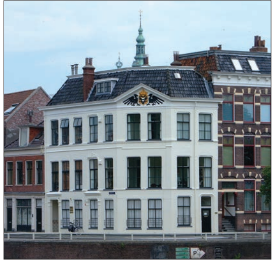
Afb. 23. Noorderhaven 64, voormalig havenkantoor na kleurherstel. Foto: Jaap Buist.
