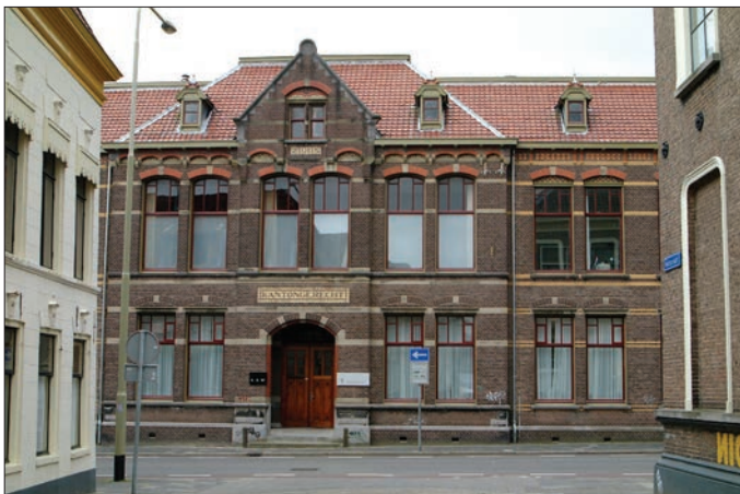
Afb. 18. Kattenhage 1, voormalig kantongerecht, na verbouw. Foto: Jaap Buist.
