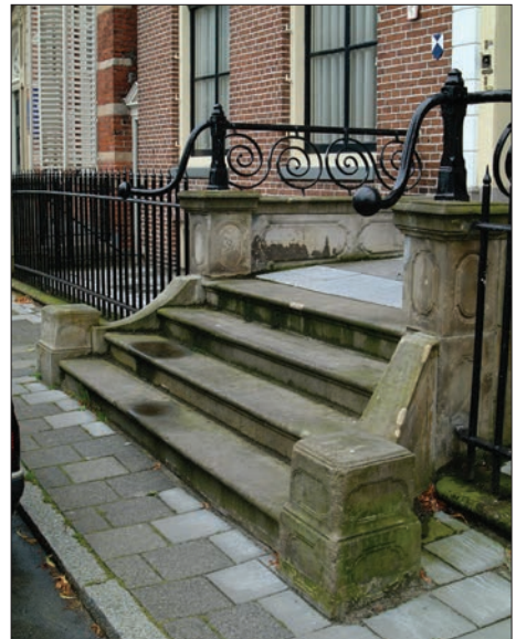
Afb. 25. Ossenmarkt 6, stoep na restauratie. Foto: Jaap Buist.
