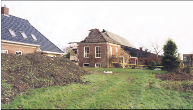
Afb. 1. Overzicht boerderij Westerseweg 2 tijdens de sloop. Foto: Marcel Verkerk.
