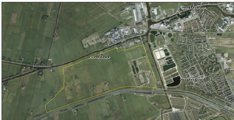
Afb. 4. Luchtfoto met daarop aangegeven het toekomstig industrieterrein Westpoort aan de A7, april 2005. Foto: KLM Aerocarto BV, Apeldoorn.
